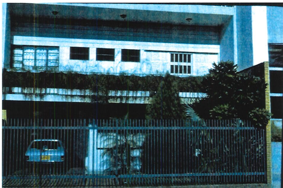
FIGURA 46 – Residência Alfredo Fonsêca Marquez – 1956 – Foto Fachada
