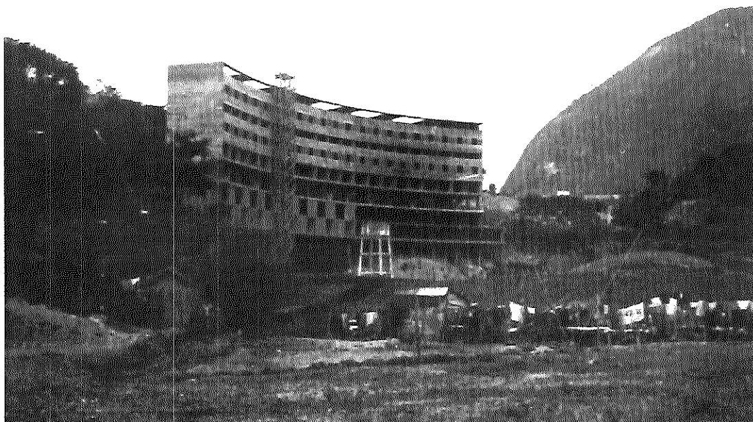
Figura 36: Foto do Conjunto em construção
