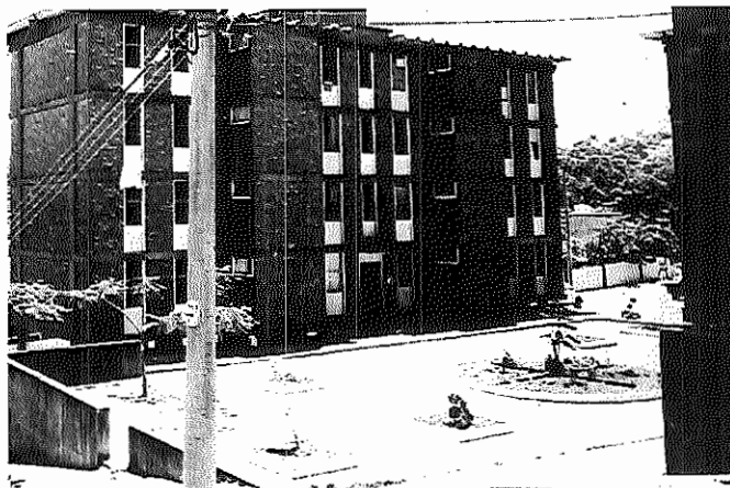
Figura 66: Vista interna do Conjunto Luís de França
