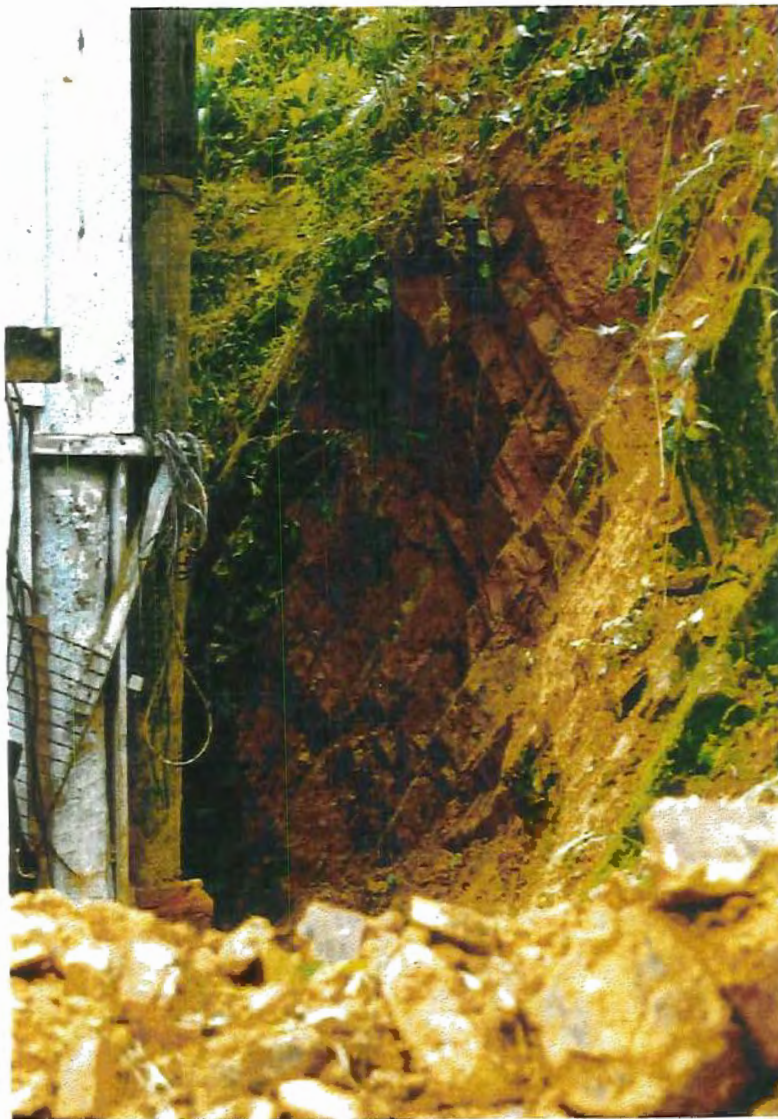
Foto 5. O terreno junto a casa com possibilidade de rápido desmoronamento - Morro do Artur - Blumenau
