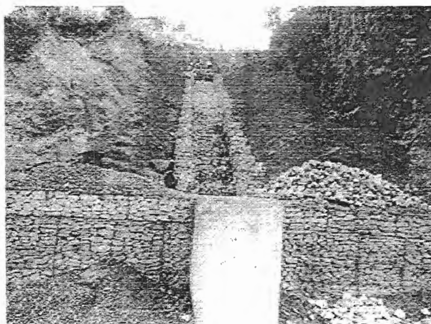
figura 24. Serviços de execução da escada hidráulica em gabões tipo caixa, após reconstituição do talude. O muro para contenção aparece em primeiro plano e logo após a caixa de passagem.
