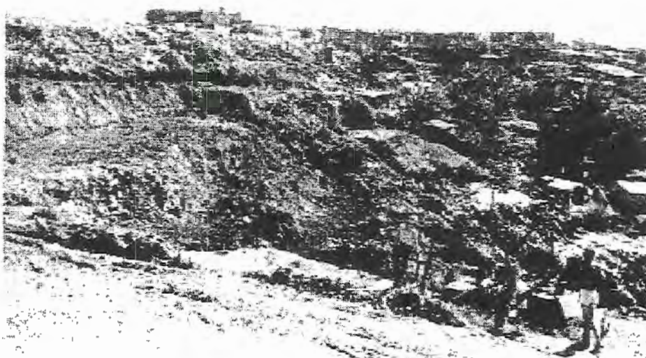
Figura 17. Após remoção dos barracos, inicia-se o serviço de limpeza da área.
