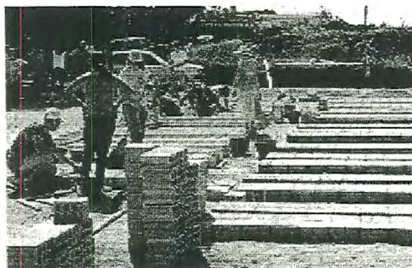
Figura 48. Sistema Construtivo em painéis de tijolos, arq. Juan Vilá. Fabricação dos painéis: Núcleo Residencial com 80 unidades e Centro Comunitário. Veranópolis, RS, 1988. 400
