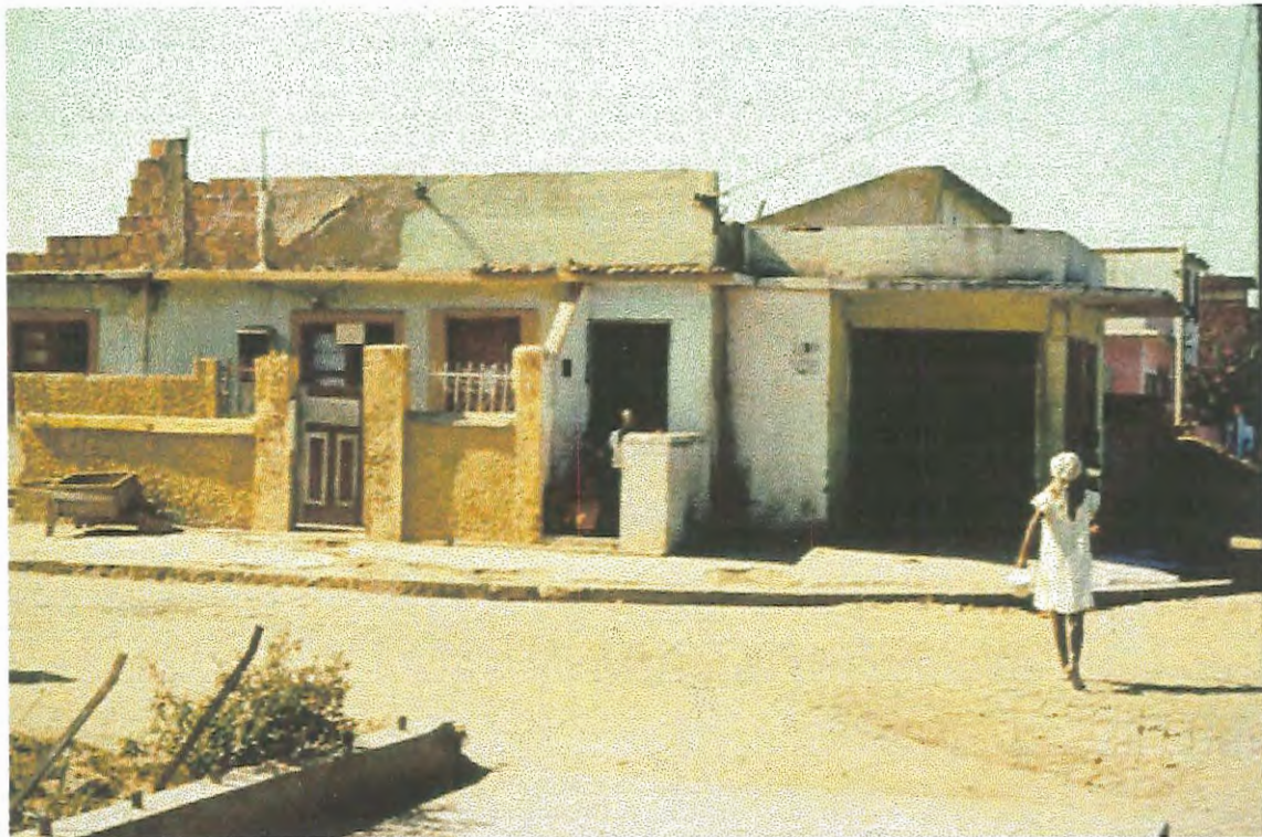
FOTO121- DEPOIS DA OBRA
