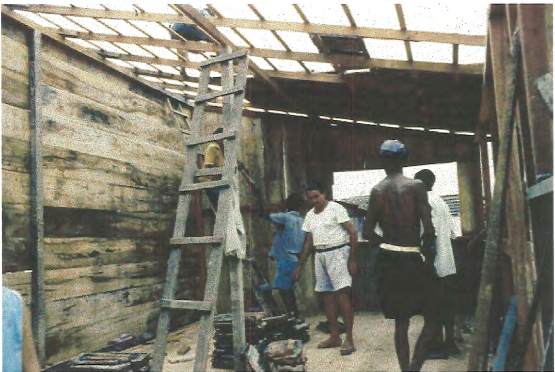
FOTO 55A - RECONSTRUÇÃO BARRACOS
