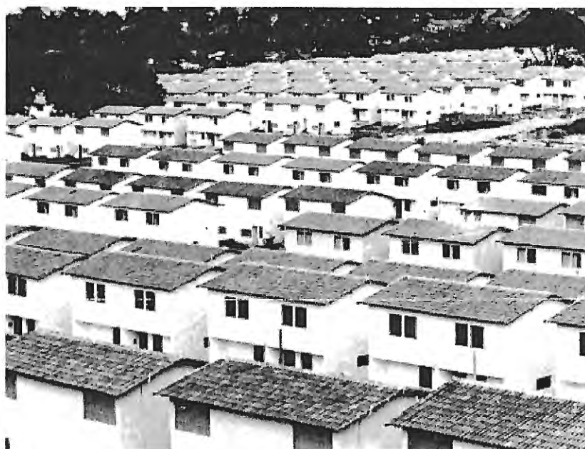
Figura 5: Conjunto Habitacional Arthur Lundgren: implantação de uma tipologia arquitetônica e urbanística que se espalhou pelas cidades do país
