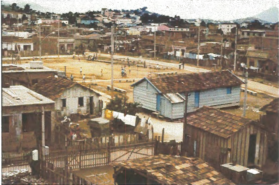
FOTO 134 - DEPOIS DA OBRA
