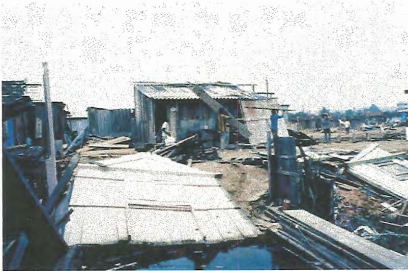
Figura 26: Desmonte de barracos
