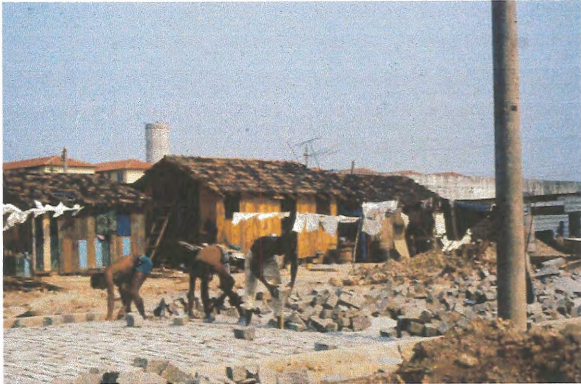
FOTO 73 - VISTA DA OBRA
