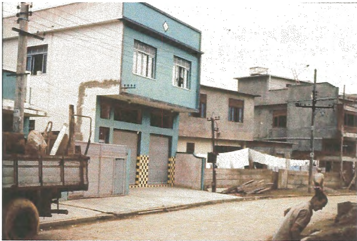
FOTO 125 - DEPOIS DA OBRA
