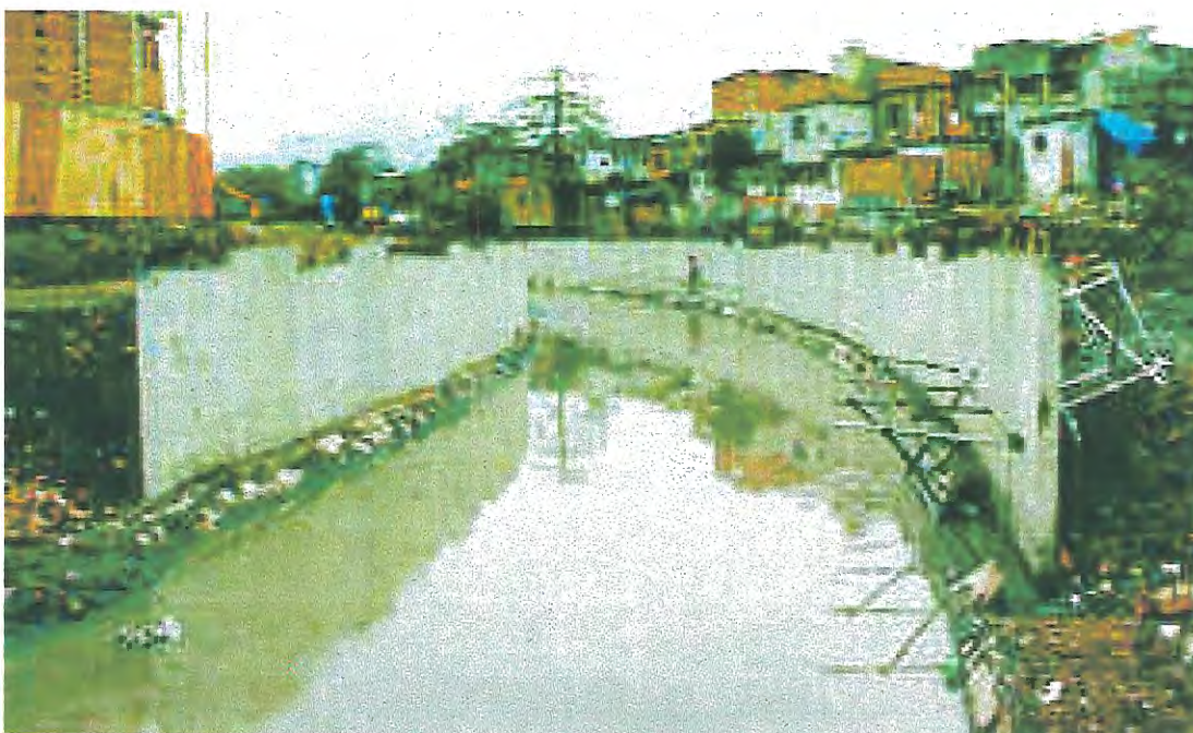
Figura 13: Exemplo de intervenções do programa Favela-bairro (durante as obras)
