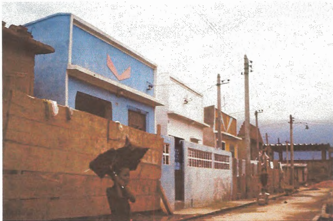
FOTO 123 - DEPOIS DA OBRA
