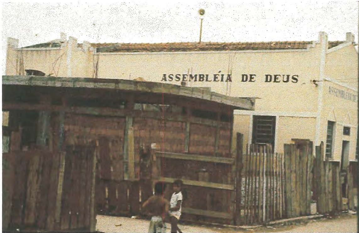
FOTO 124 - DEPOIS DA OBRA
