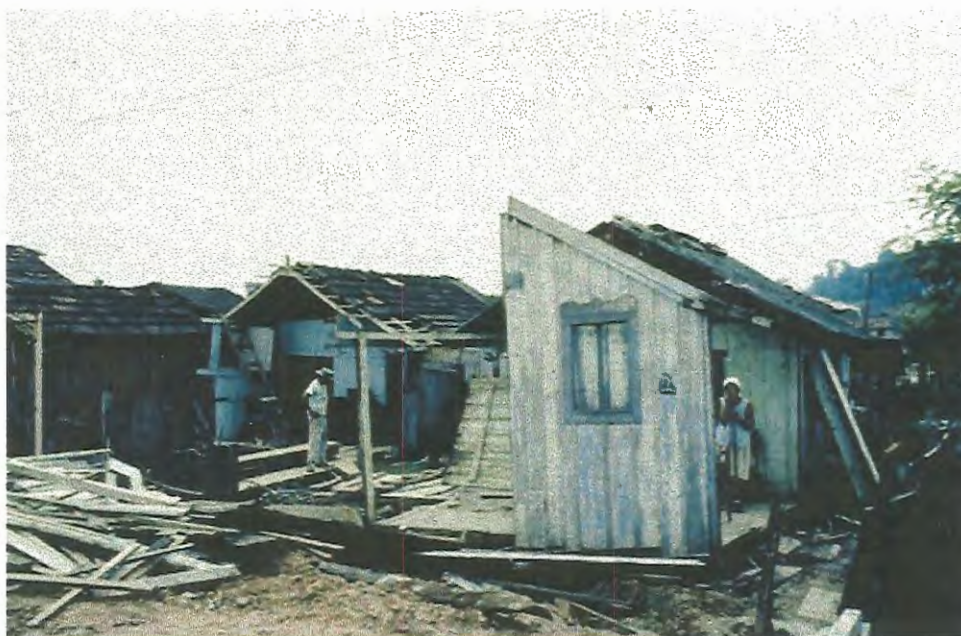
Figura 25: Desmonte de barracos feito para remanejamento do mesmo.
