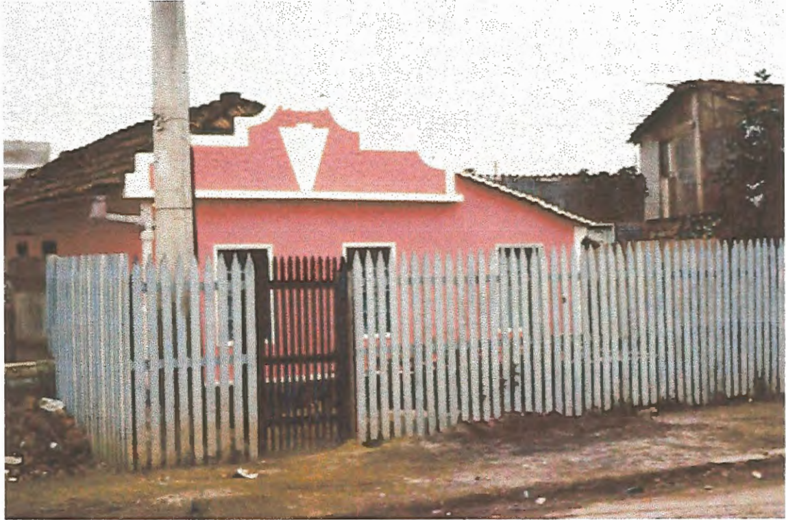
FOTO 131- DEPOIS DA OBRA
