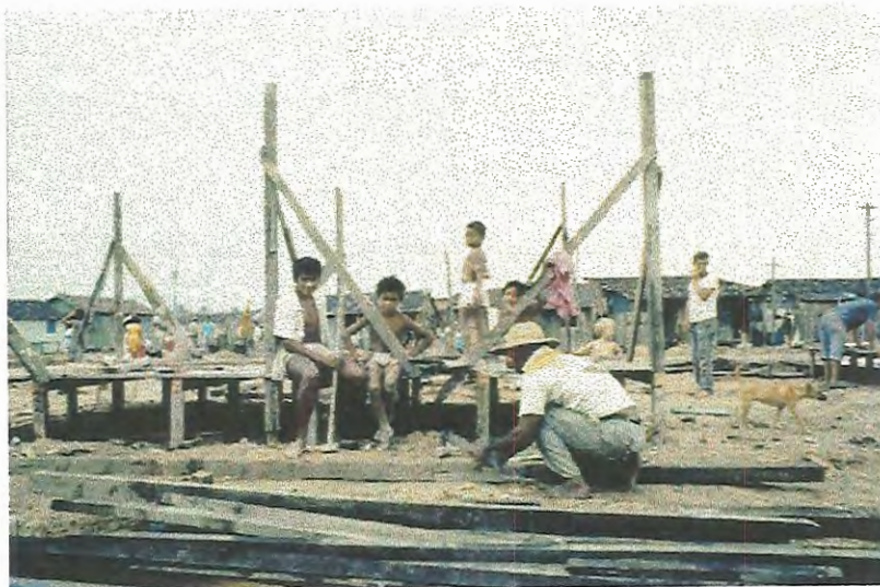
Figura 29: Reconstrução de barracos remanejados
