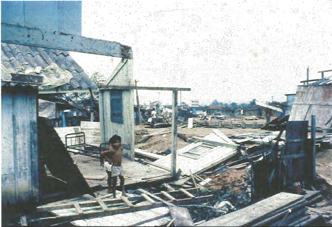
FOTO 53A - DESMONTE BARRACOS
