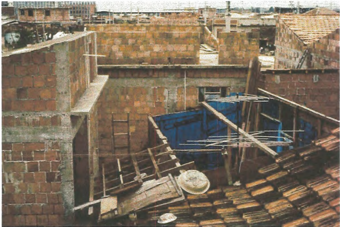
FOTO 132 - DEPOIS DA OBRA
