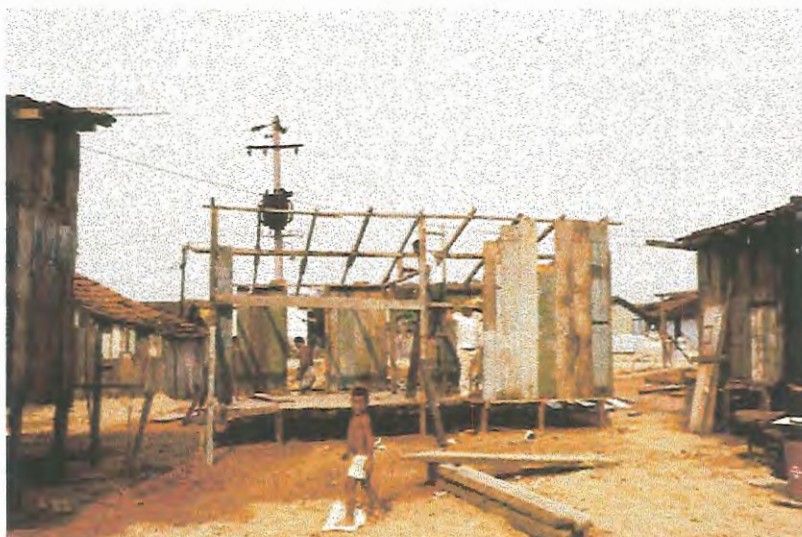
Figura 28: Reconstrução barracos em novo local.
