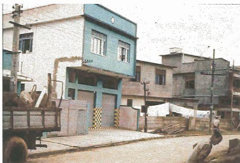
Figura 45: Depois da obra (não havia data nesta foto, mas depreende-se que é do mesmo ano 1971)
