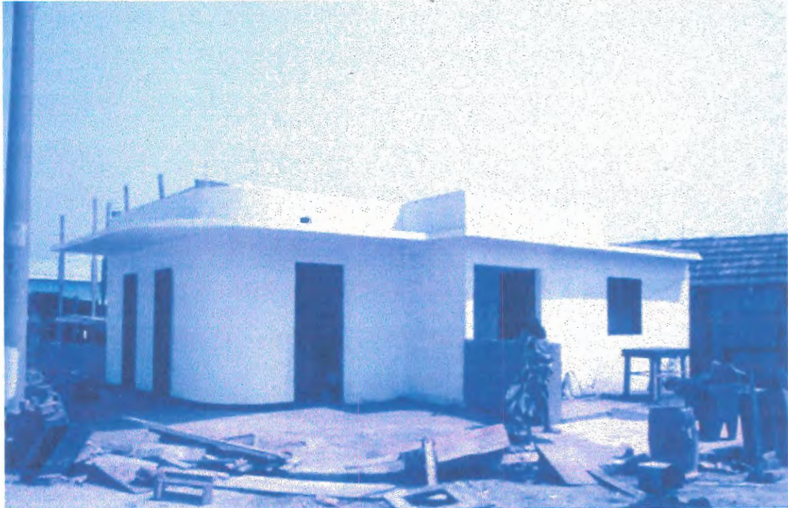
FOTO 120 - DEPOIS DA OBRA
