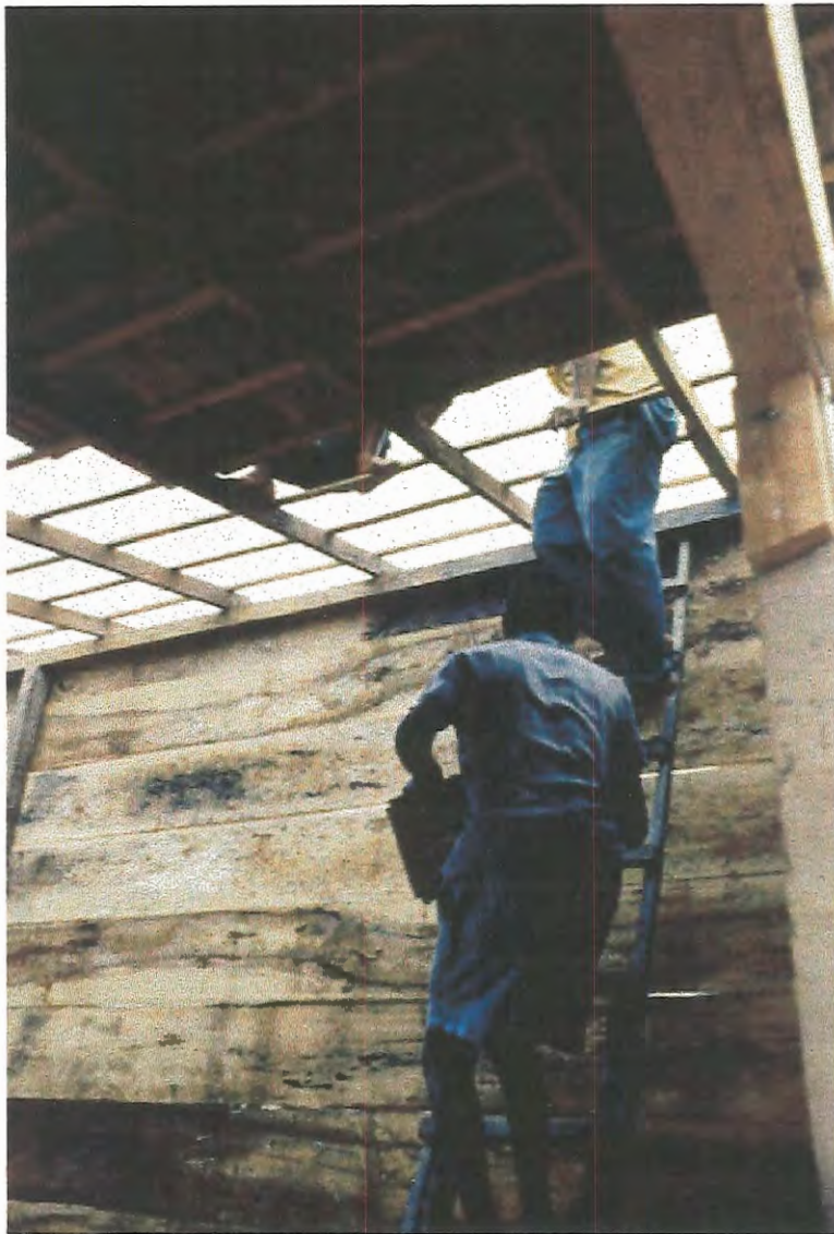
FOTO 55B- RECONSTRUÇÃO BARRACOS
