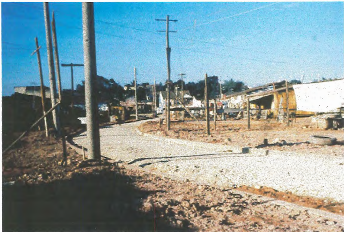
FOTO 75 - VISTA GERAL APÓS A OBRA
