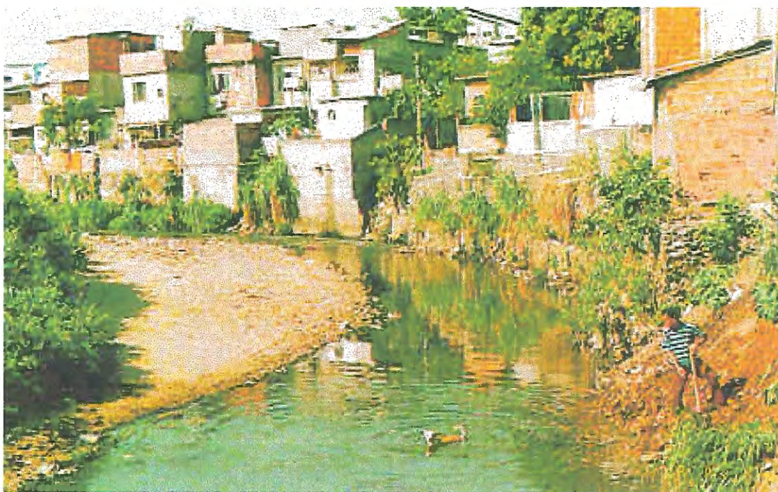
Figura 12: Exemplo de intervenções do programa Favela-bairro (antes das obras)
