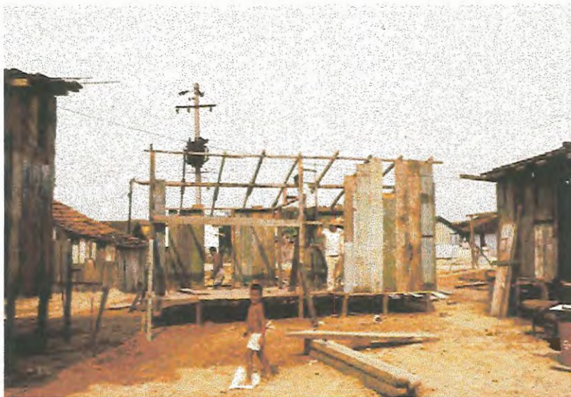
Figura 27: Desmonte de barracos
