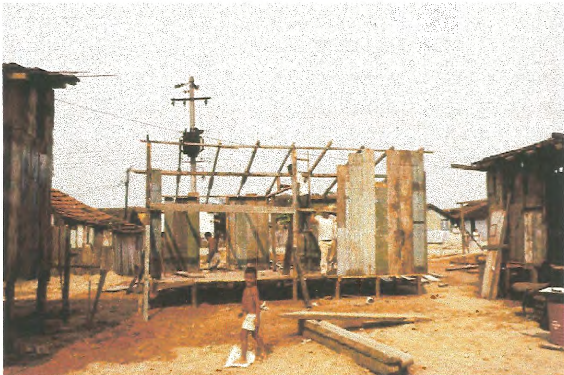
FOTO 53B - RECONSTRUÇÃO BARRACOS
