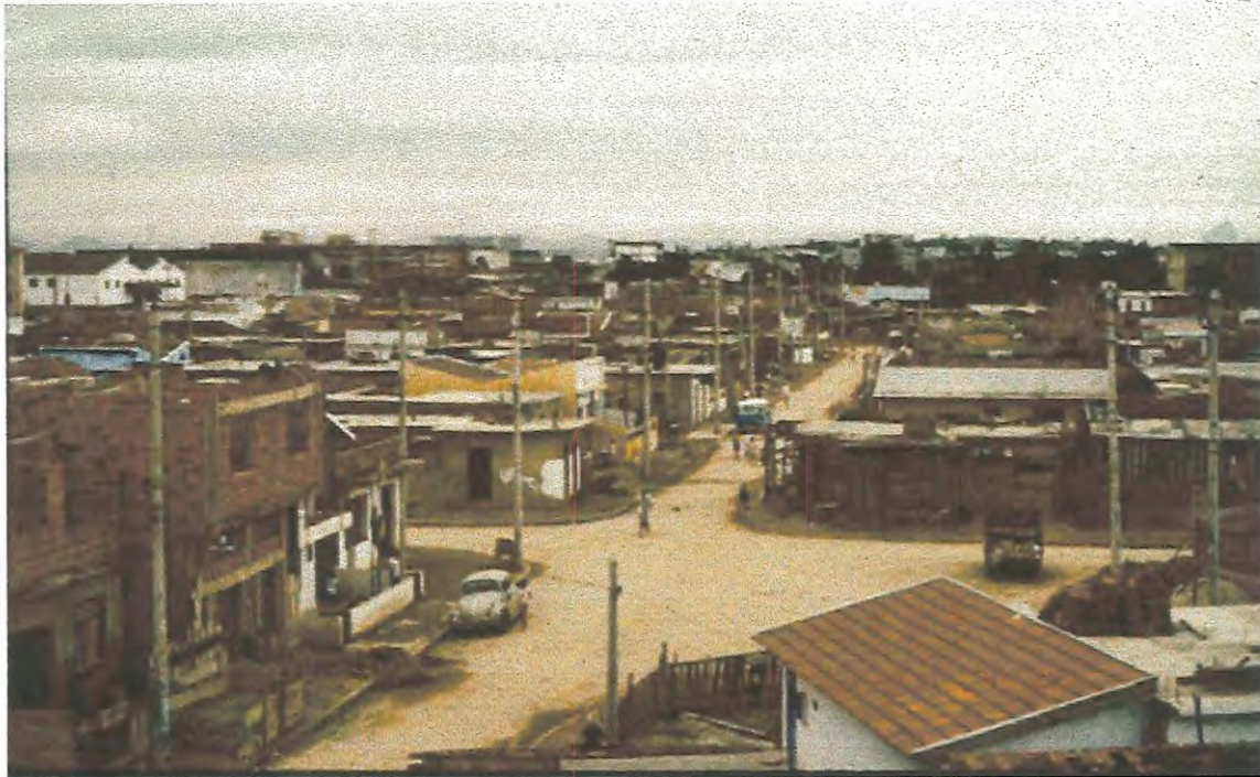
FOTO 136 - VISTA GERAL DEPOIS DA OBRA
