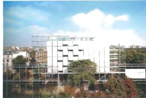
"Roller blinds" móveis localizados externamente oferecem efetiva proteção solar e o calor é re-irradiado no lado de fora do edifício. Lotus 84 p. 53. Fachada principal da Fundação Cartier (Roller blinds). O vidro é claro. As Fachadas Oeste e Sul filtram o sol através de sistemas Roller blinds
