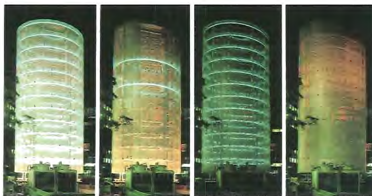
Torre dos Ventos (Arca 15, pp. 34e 35)
