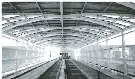
Painéis de vidro impresso com vários padrões criaram uma transparência controlada no corredor de passageiros do Munich II airport, 1991-92, Murphy & Jahn COMPAGNO (1996), p.39.
