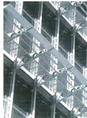
Headquarters of the HongKong and Shanghai Bank, HongKong, 1979-86, Norman Foster. A opção de sombreamento solar foi desenvolvida com persianas fixas em um determinado ângulo. O projeto desse sistema oferece proteção efetiva sem a obstrução da paisagem vista do interior do edifício. COMPAGNO (1996), p.78.
