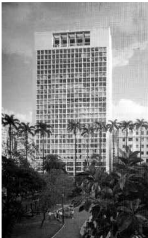
Lucjan Korngold: Edifício CBI-Esplanada, São Paulo, 1946 fonte: SEGAWA, 1999, p. 135
