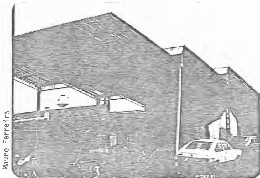
Paradigma da arquitetura industrial em Franca. A moderna estrutura pré-fabricada sobrepõe-se à velha residência, que continua funcionando até a conclusão da obra.
