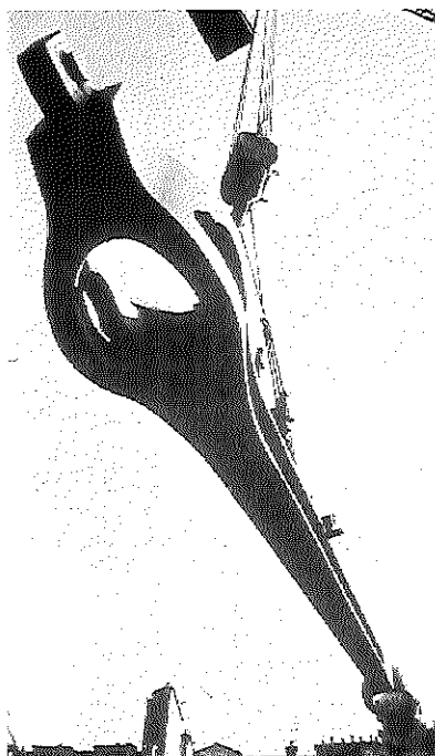
92, 93 Centre Georges Pompidou – 1971/77 elementos estruturais – “nó” A+U, 3/1989
