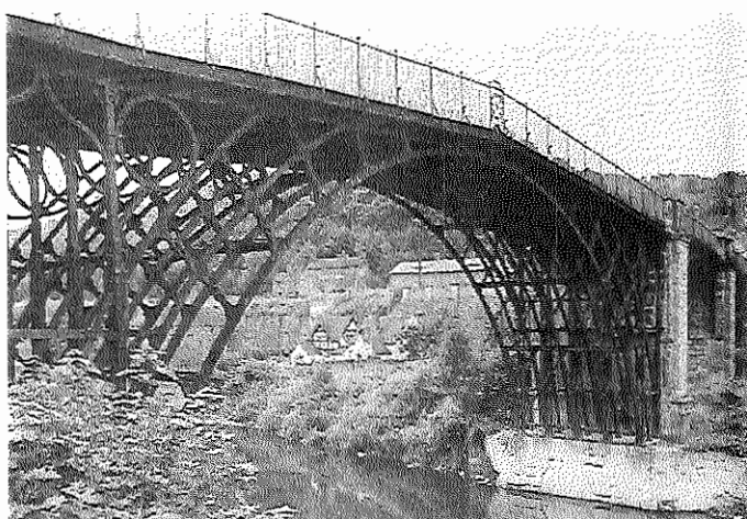
3. Ponte sobre o rio Severn, próximo à cidade de Coalbrookdale, Inglaterra, 1777 Pevsner, 1996
