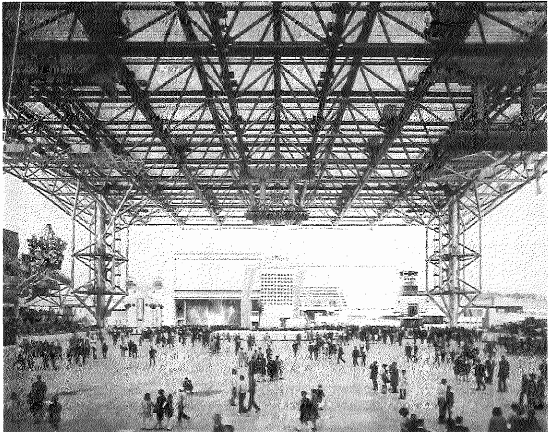
31. Kenzo Tange, Pavilhão Grande Praça do Sol na Expo Osaka 1970. É uma construção retangular de 100x250m, com malha em pirâmide quadrada. Suas barras tem cerca de 10m de comprimento e os nós mais de 1m de diâmetro. L'Architecture d'Aujourd'hui
