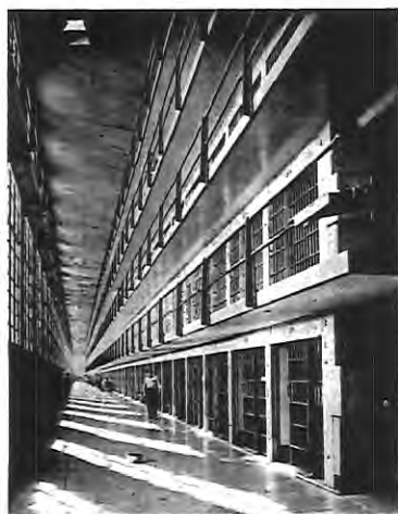
Figura 45- Longo corredor da prisão de Auburn.
