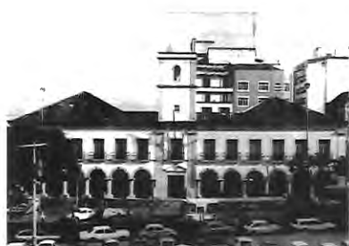
Figura 60- Casa de Câmara e Cadeia em Salvador – BA, construção do século XVII.
