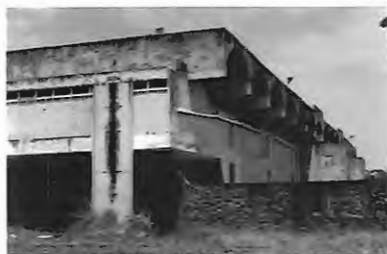
Figura 96 – Vista externa do Pavilhão de celas, FEBEM de Ribeirão Preto.
