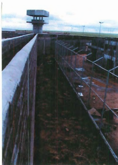
Figura 107 – Zona de Tiro, entre o alambrado e a muralha da Penitenciária de Segurança Máxima que está sendo construída na cidade de Ribeirão Preto.
