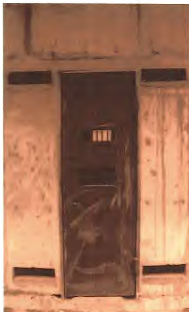
Figura 111 – Porta de uma das celas da Penitenciária de Segurança Máxima que está sendo construída na cidade de Ribeirão Preto. Segue o modelo Cruz.
