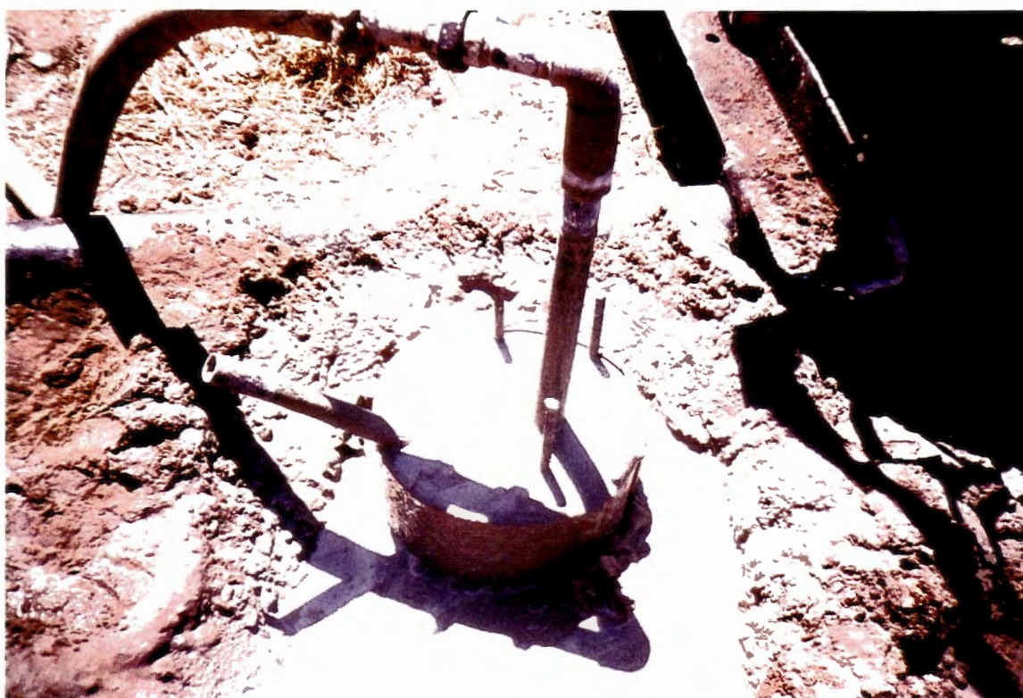
FIGURA 3.5 - Preenchimento do fuste com argamassa.
