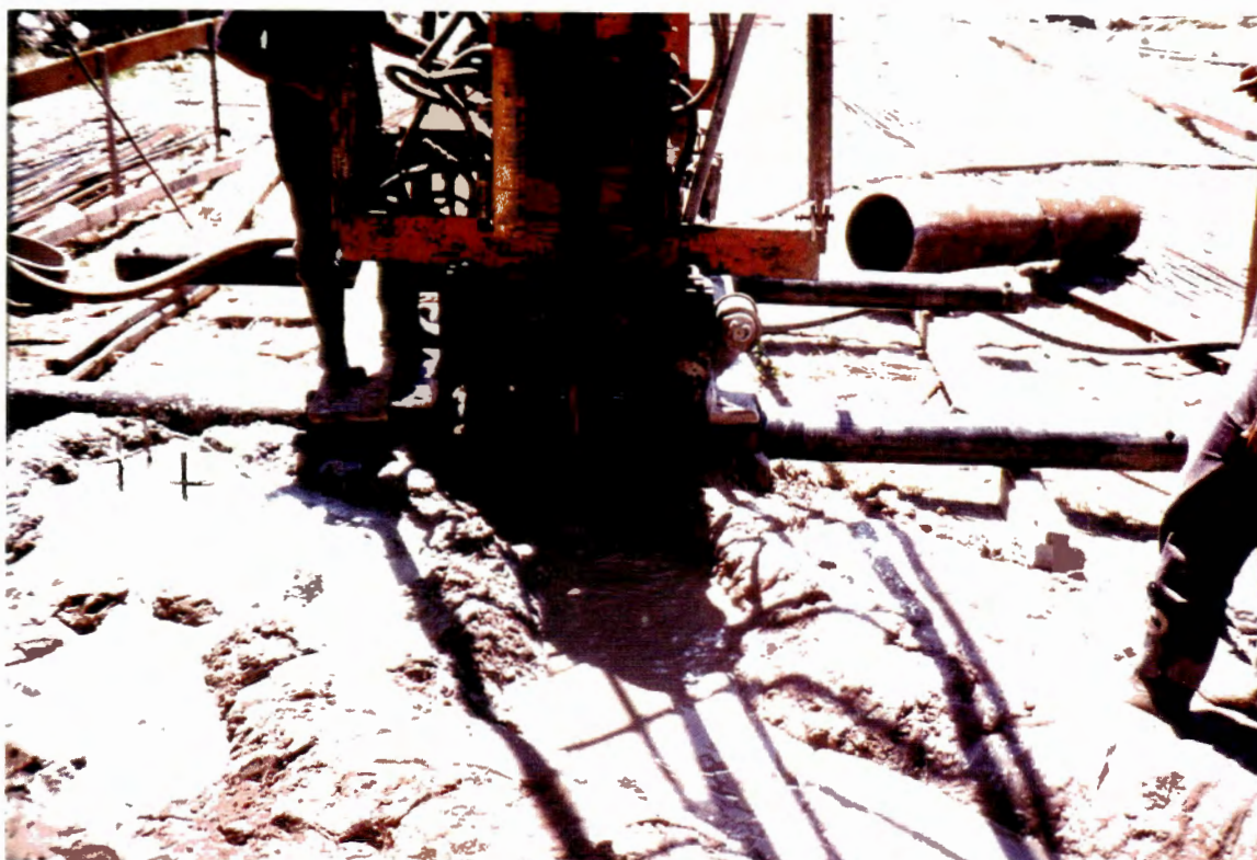
FIGURA 3.2 - Início da perfuração da estaca Rotativa-Injetada.
