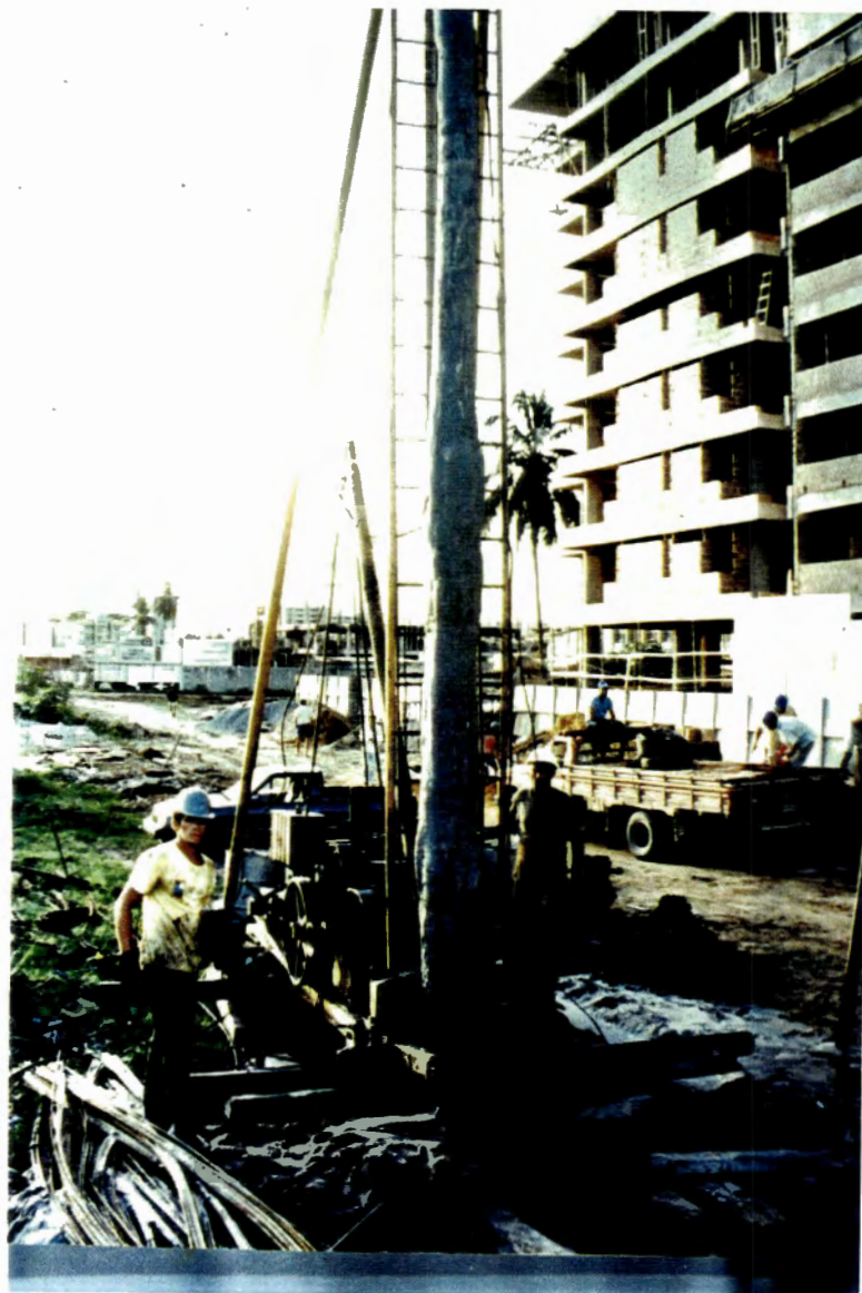
FIGURA 3.10 - Uma estaca Rotativa-Injetada extraída de subsolo arenoso, de compacidade fofa a compacta.
