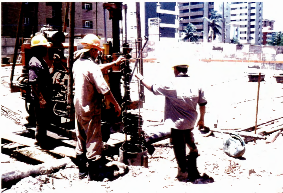
FIGURA 3.4 - Colocação da armadura.
