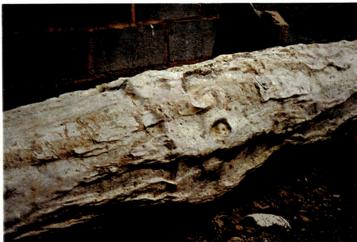
FIGURA 3.11 - Detalhe da rugosidade do fuste da estaca extraída, mostrada na Figura 3.10.
