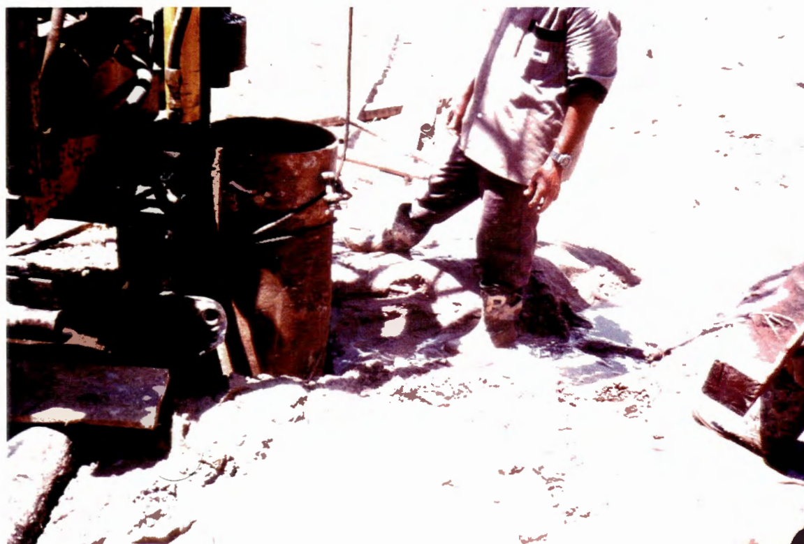
FIGURA 3.3 - Colocação do tubo guia.
