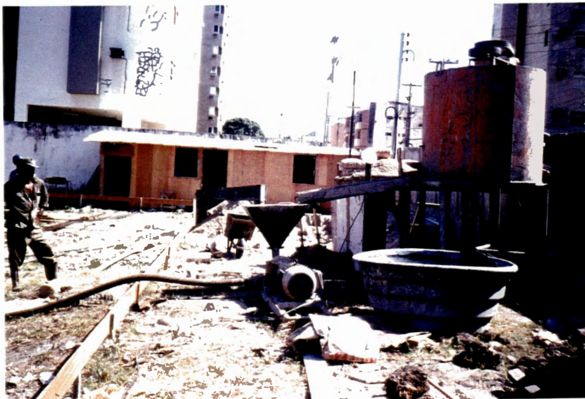
FIGURA 3.6 - Misturador e bomba de injeção de argamassa.
