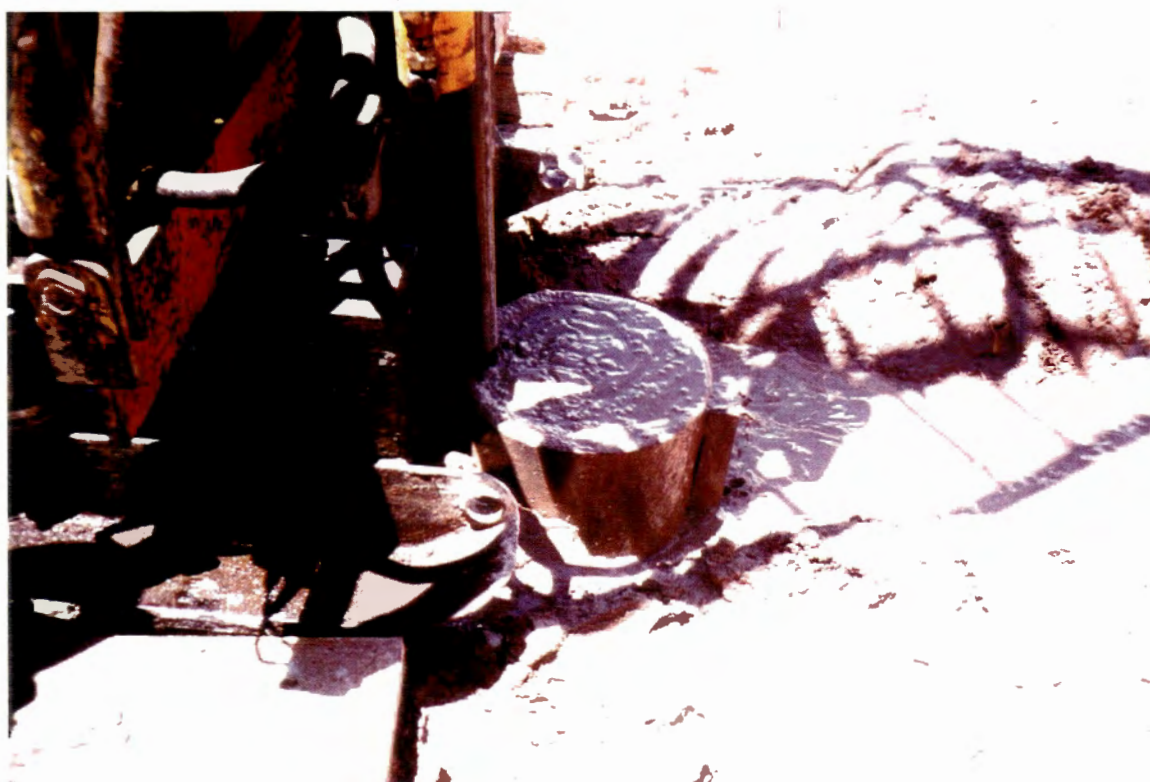
FIGURA 3.7 - Execução do alargamento proposital do fuste ("bulbos").
