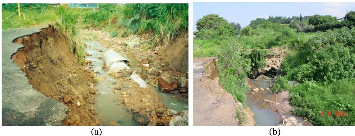
Figura 7.54: Local onde as obras de drenagem foram rompidas pelas águas pluviais e abandonada pela administração pública. (a) Foto obtida em abril de 2002. (b) Foto obtida em novembro de 2005.
