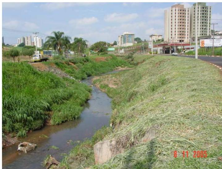
Figura 7.48: Foz do Córrego Gregório sem mata ciliar ou faixa de proteção. Em época de chuvas intensas, águas pluviais são lançadas de altas declividades, aumentando a velocidade do fluxo do canal, provocando inundações.
