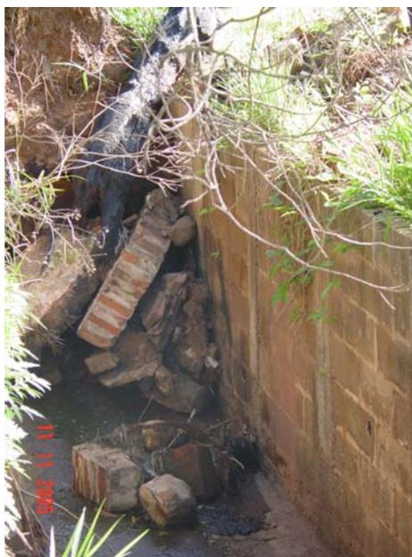
Figura 7.24: Obra de controle da erosão destruída pela força das águas pluviais, na região da mineração abandonada.
