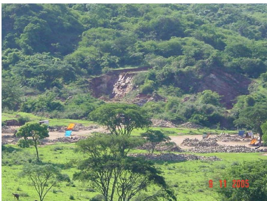
Figura 7.70: Pedreira em atividade; exploração dos arenitos silicificados da Formação Botucatu.
