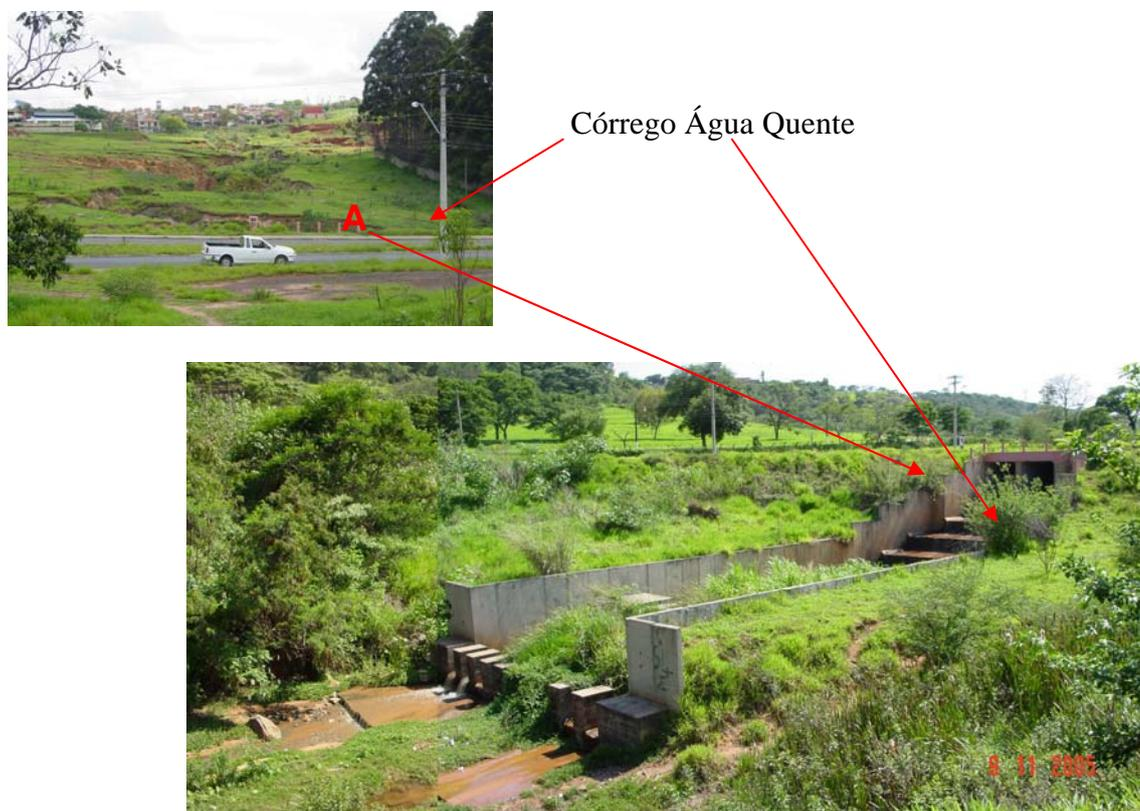
Figura 7.12: Dissipador de energia construído no Córrego Água Quente a fim de estabilizar o processo erosivo instalado no local.
