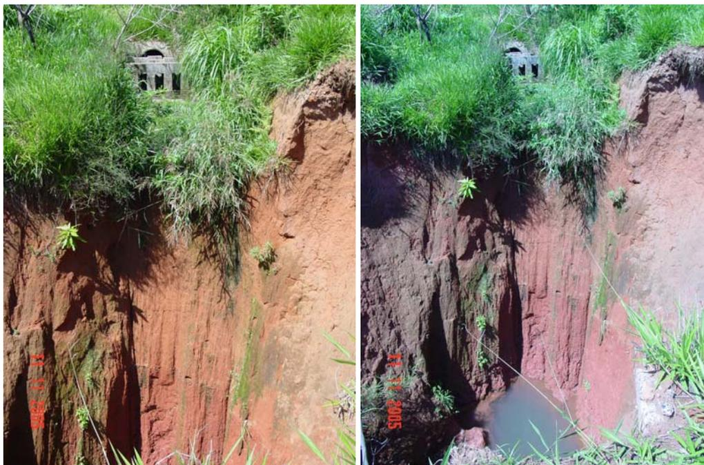
Figura 7.61: Erosão formada na nascente do rio Monjolinho, apesar da existência de obra de drenagem.
