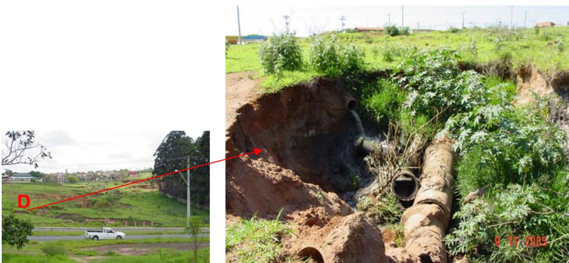
Figura 7.15: Rede de drenagem de esgoto doméstico rompida, provocando a contaminação do solo e a instabilização do processo de controle da erosão.
