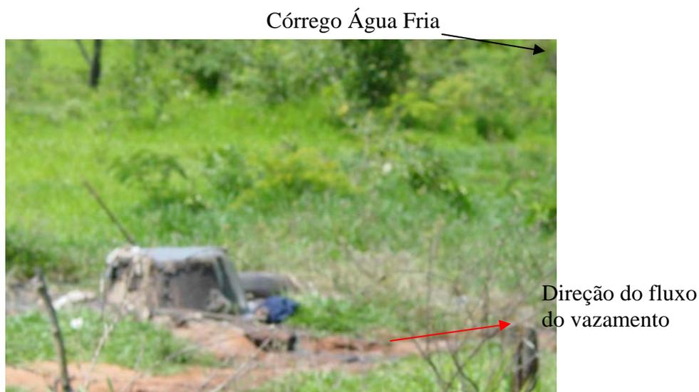
Figura 7.33: Vazamento da fossa séptica nos fundos de uma casa no bairro Cidade Aracy, onde a topografia carrega o fluxo na direção do Córrego Água Fria.
