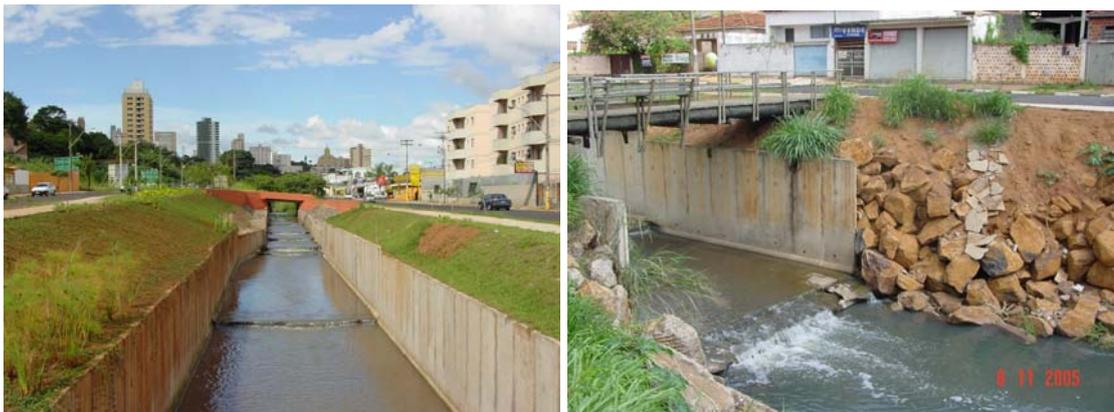
Figura 7.47: Canal do Córrego Gregório retificado e revestido com concreto.
