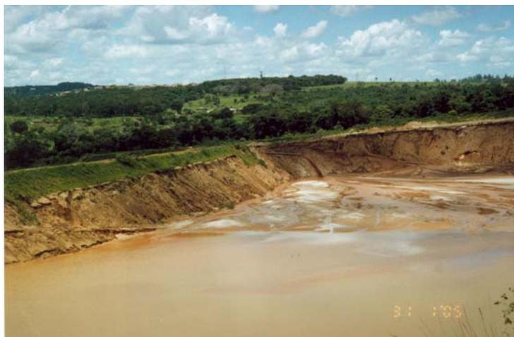
Figura 7.36: Área de depósito do rejeito da extração de areia. Barragem com aproximadamente 4 metros de profundidade.
