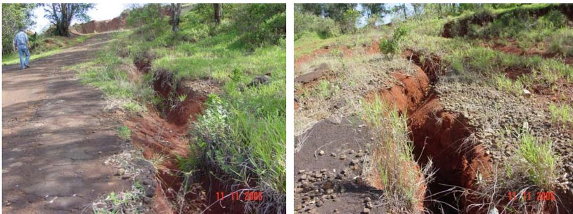
Figura 7.67: Sulcos de erosão provocados pela alta declividade, ausência de vegetação e fluxo de águas pluviais com alta velocidade.
