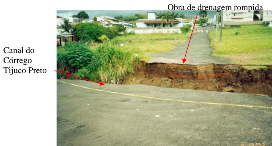
Figura 7.53: Obra de drenagem no Córrego Tijuco Preto rompida pela força das águas pluviais.
