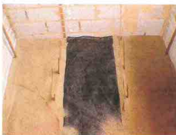
Figura 3.8 - Disposição da manta de geotêxtil
