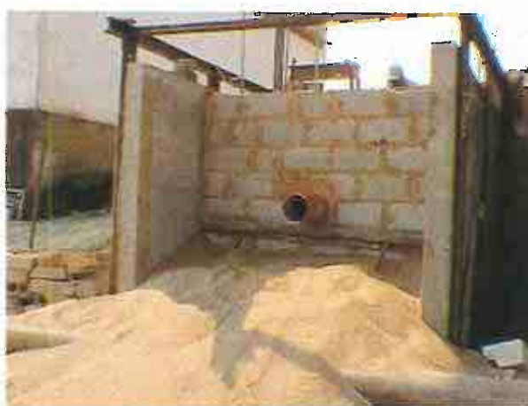
Figura 3.1 - Vista frontal do muro
