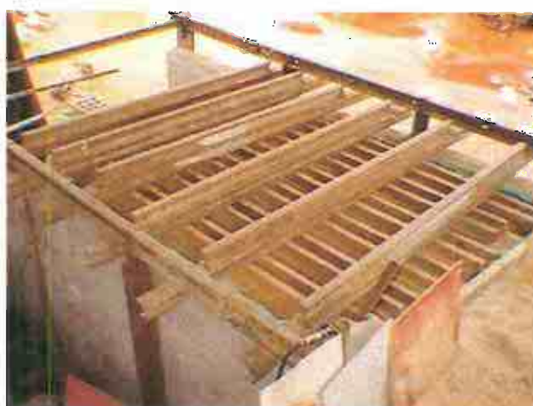
Figura 3.4 - Disposição das tábuas e trilhos horizontais
