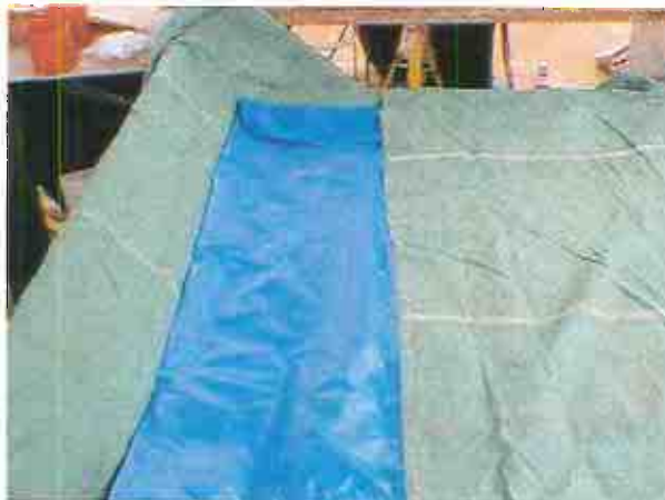
Figura 3.3 - Revestimento da bolsa de reação
