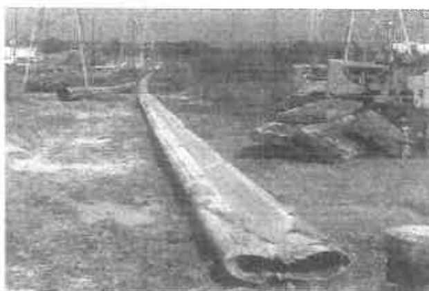
Figura 2.21 - Ruptura típica de um conduto flexível (O'donnell, 1996)
