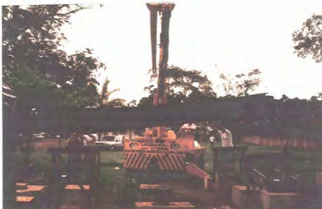
Foto 05 - Deslocamento da viga de reação
