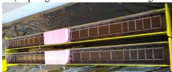
c) Tipologias 3 e 6 antes da concretagem
