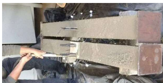
b) Tipologias 1 e 2 depois da concretagem
