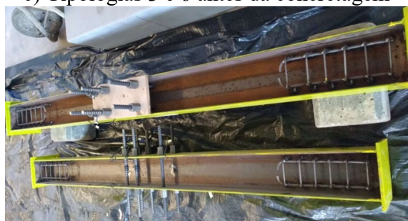
e) Tipologias 4 e 5 antes da concretagem
