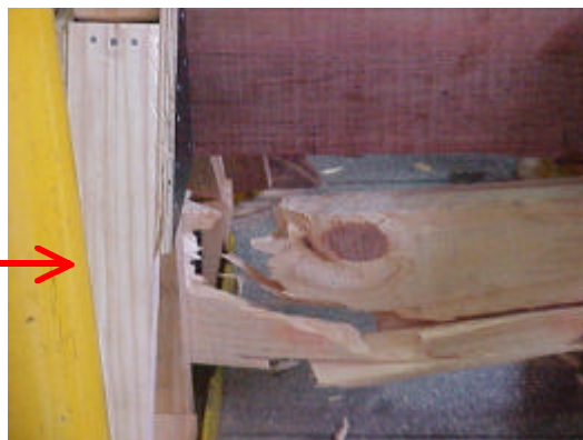
Figura 112 – Detalhe da ruptura.
