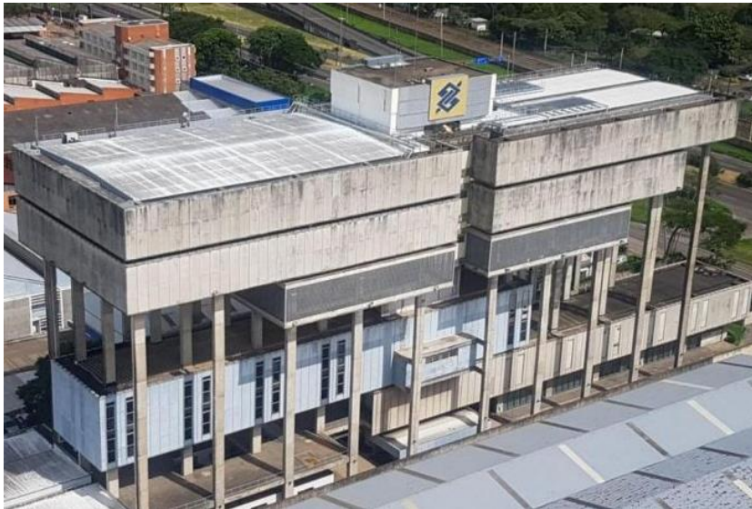
Figura 1-1 – Edifício com pilares esbeltos em concreto armado.
