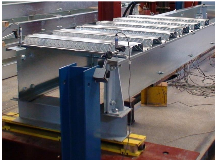
Figura 3.5 – Travamento lateral de extremidade por meio de painéis steel deck parafusados.
