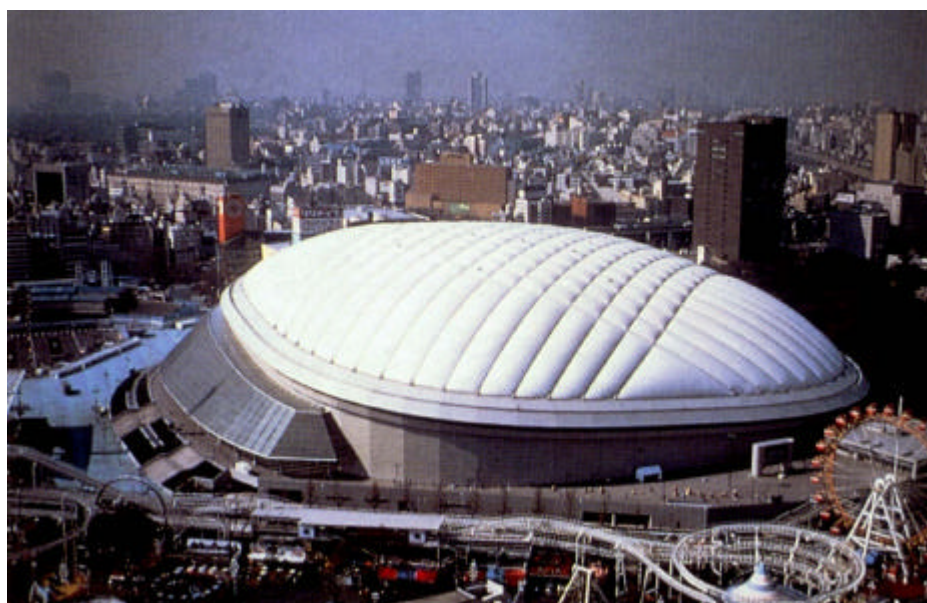
FIGURA 1.4: Estrutura pneumática, Tokyo Dome , Japão (FORSTER,1994)
