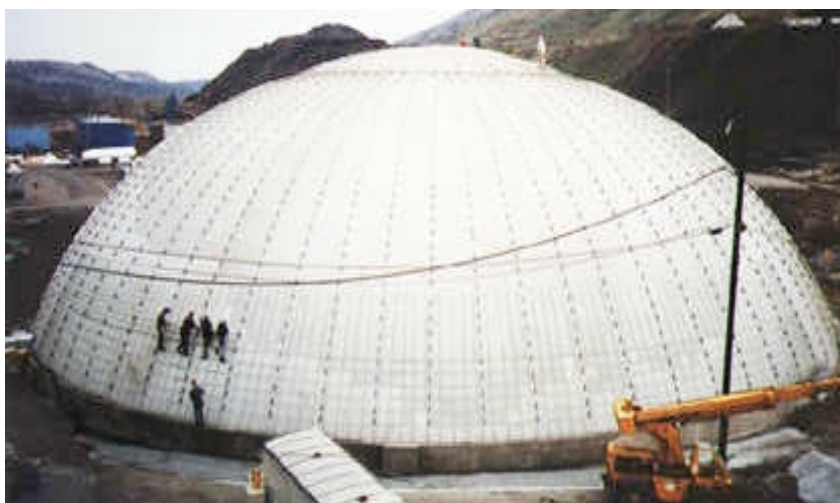
FIGURA 2.2.10: Emprego de Estrutura Pneumática como Fôrma para Casca de Concreto (TENSAR, 1999).
