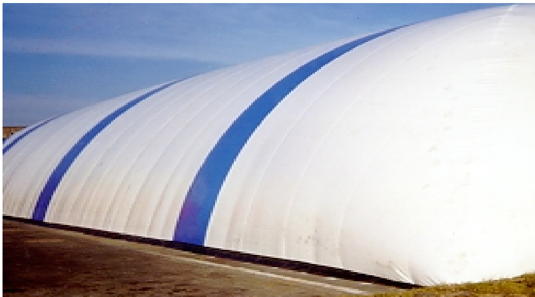
FIGURA 6.1.1: Armazém Industrial no Brasil [Fonte: Pistelli Engenharia Ltda (1997)].
