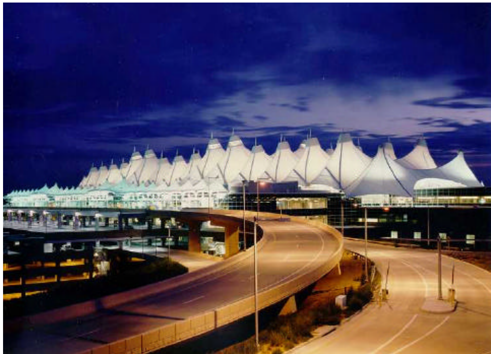
FIGURA 1.1: Estrutura de membrana protendida por cabos, Aeroporto Internacional de Denver (ROBBIN, 1996).
