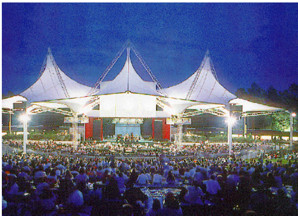
FIGURA 1.2: Estrutura de membrana protendida por cabos, Cynthia Woods Mitchell Center , Texas (ROBBIN,1996).
