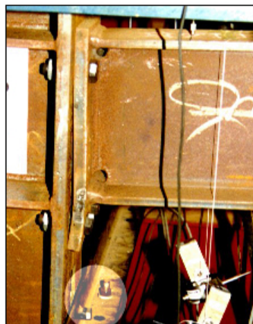
Figura 6.9 – Deformada final do protótipo CT1B-6 No detalhe, parafusos da linha interna após a ruptura
