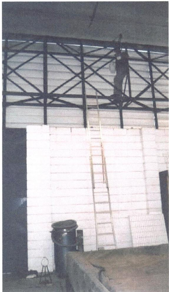
Posteriormente o tubo foi içado utilizando o próprio sistema de roldana e corda com um gancho fixado na parte inferior do tubo e a corda passando por dentro do mesmo. Posicionado o tubo o mesmo foi fixado por meio das braçadeiras (Figura 5.6).
