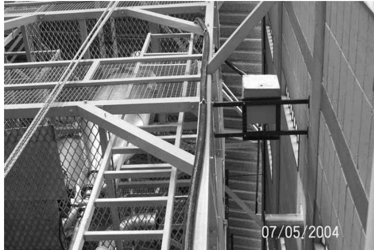
Figura 3.26 – Vista da caixa quente e de parte da linha de amostragem de gases utilizada na planta piloto.
