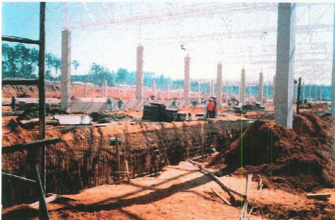
Foto 11.2: Obra do canal de resfriamento de óleo de usinagem.
