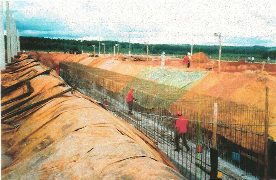
Foto 8.2: Canal de resfriamento de óleo de usinagem, Volkswagen.
