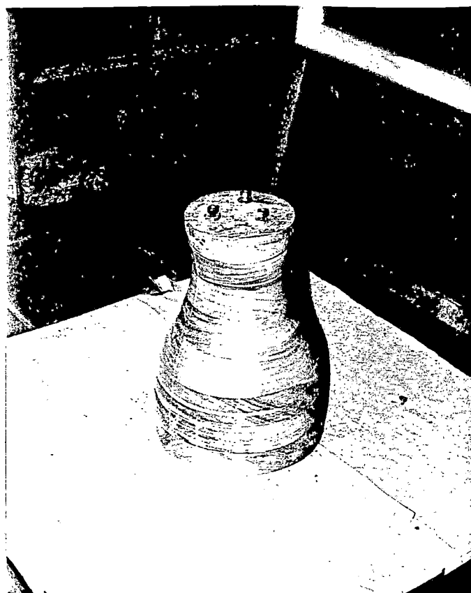
FIGURA 16 - Vista do molde de madeira montado.
