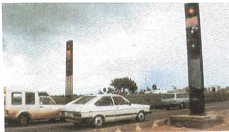
FIGURA 04 - Lombada eletrônica em Brasília: um dos instrumentos para a segurança viária. Fonte: ANTP – Associação Nacional de Transportes Públicos (1997).
