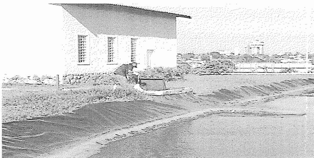
**FOTOGRAFIA 4.14** – Fotografia mostrando a coleta da amostra depois dos UASBs, correspondendo à entrada da lagoa aerada.
