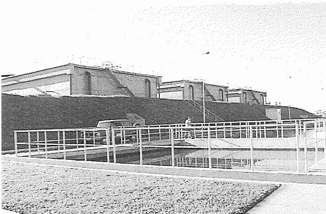
**FOTOGRAFIA 4.1** – Fotografia dos 3 módulos de reatores anaeróbios (UASBs).
