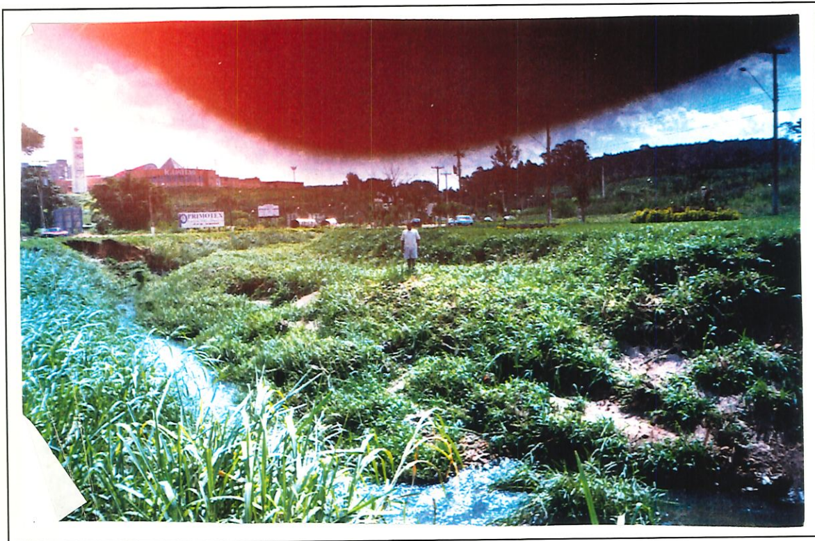
Foto 3: Abatimento do talude do Córrego do Gregório em seu setor não canalizado. (Foto da Autora - 1999).
