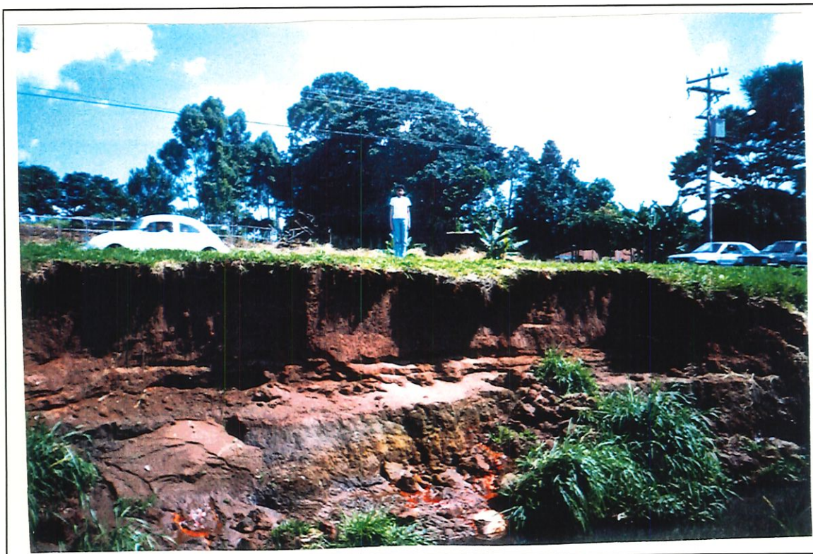
Foto 13: Desbarrancamento do talude fluvial em área sem contenção, pela ação conjunta do escoamento pluvial e fluvial. (Foto da Autora - 1999).
