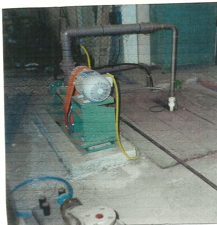
FIGURA 4.3 – CANAL DE CHEGADA DA ADUTORA E RECALQUE DA ÁGUA BRUTA
