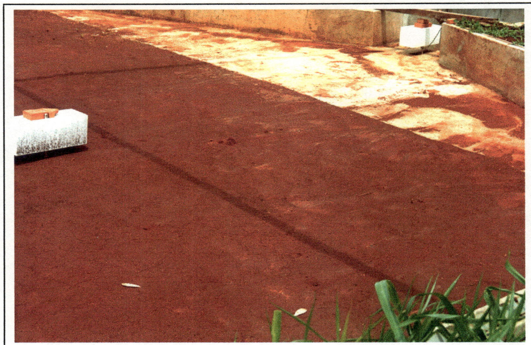
Foto 10. Detalhes do trecho final da área experimental e área de concentração (concretada) com o canal de saída para a caixa receptora de deflúvio
