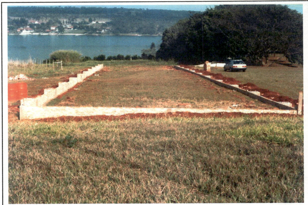
Foto 1. Delimitação da área experimental e construção das brocas de sustentação da estrutura metálica
