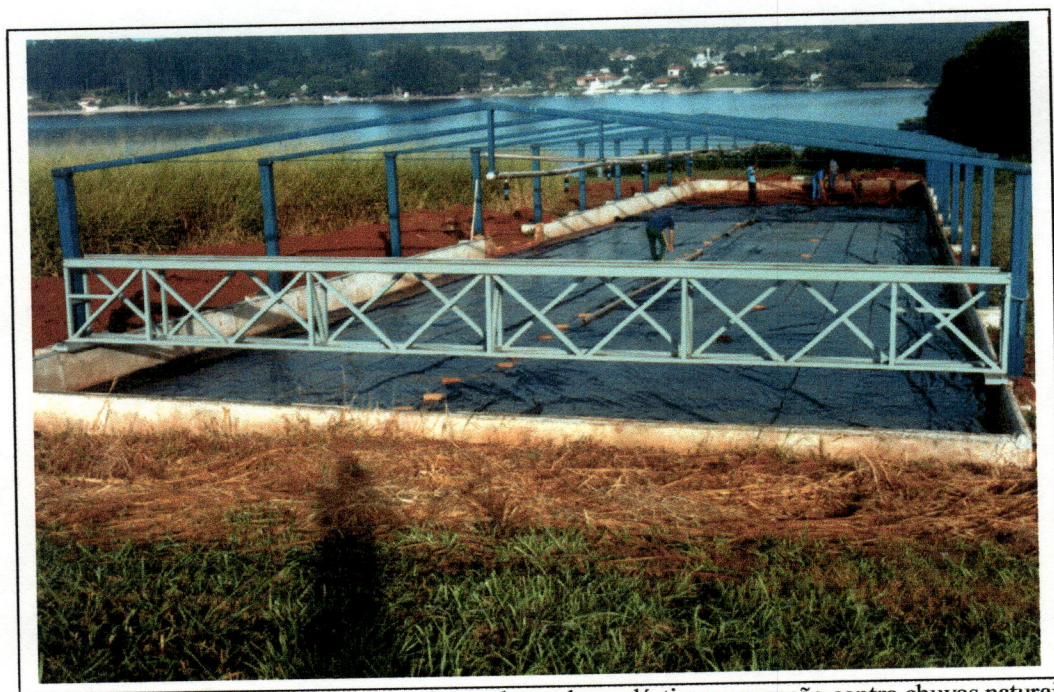
Foto 14. Proteção da área experimental com lona plástica: prevenção contra chuvas naturais
