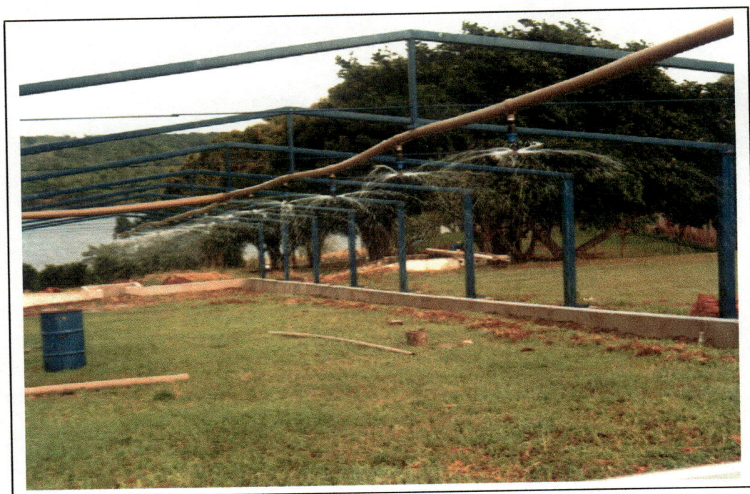
Foto 13. Despressurização do simulador de chuvas
