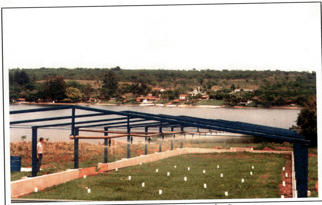
Foto 11. Vista do simulador de chuvas e início de pressurização
