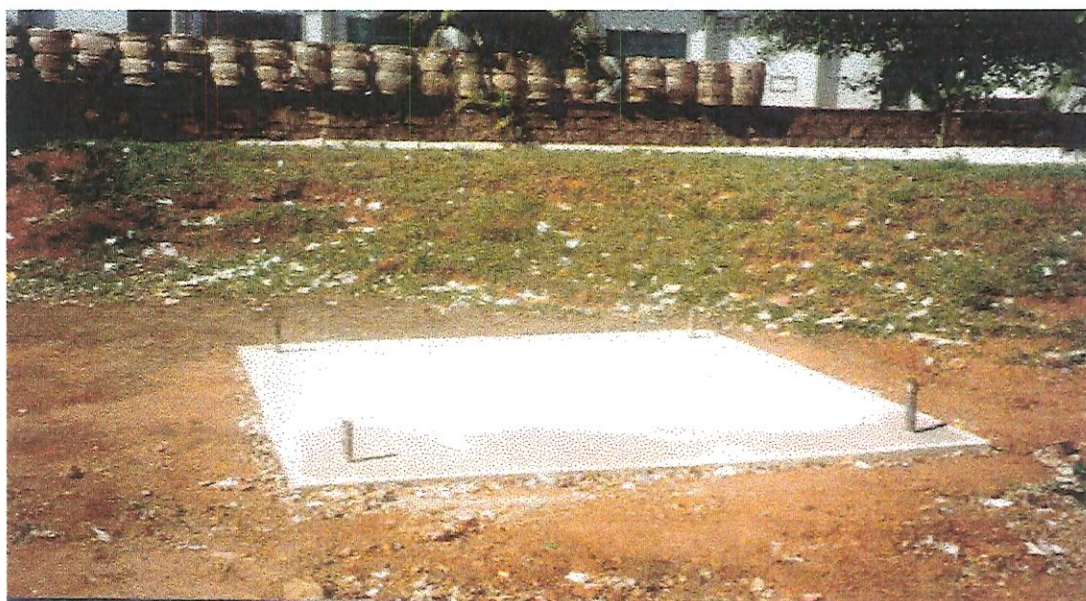
Figura 4.3 - Área cimentada para colocação da leira
