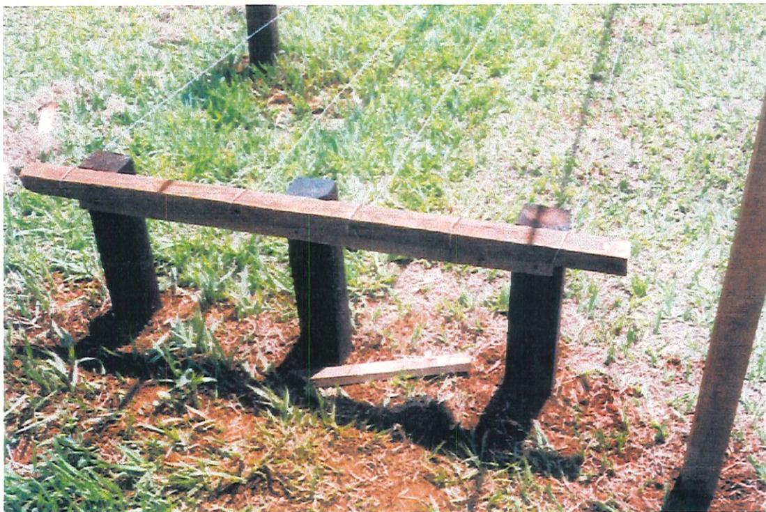
**FIGURA 7** - Estrutura de apoio das bandejas utilizando-se fios de aço tracionados por catracas no sentido longitudinal.
