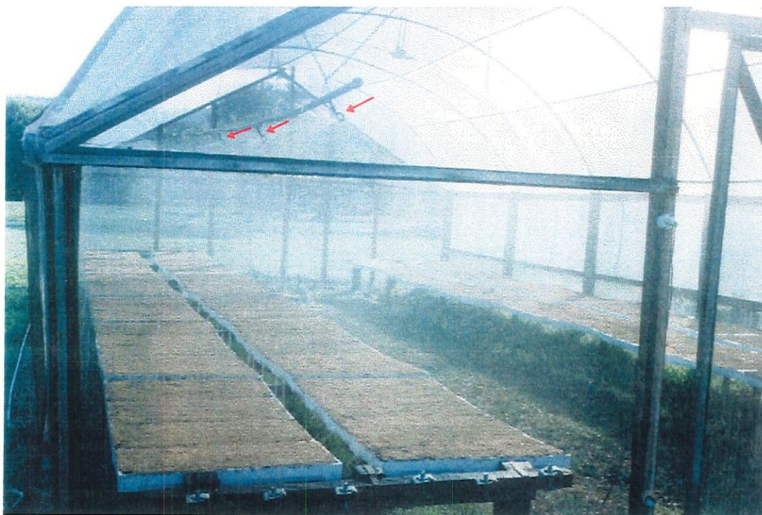
**FIGURA 6** - Vista interior da estufa com os aspersores em funcionamento.
