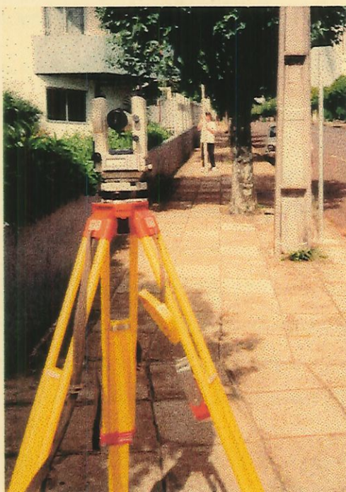
Figura 10 - Levantamentos topográficos nas ruas Araribóia e Itapuã.
