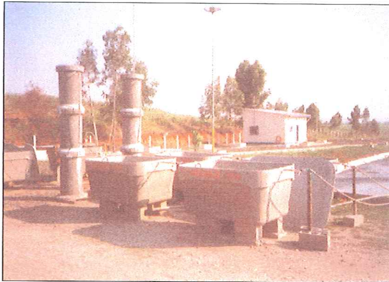
FIGURA 45 - Vista geral da unidade piloto montada
