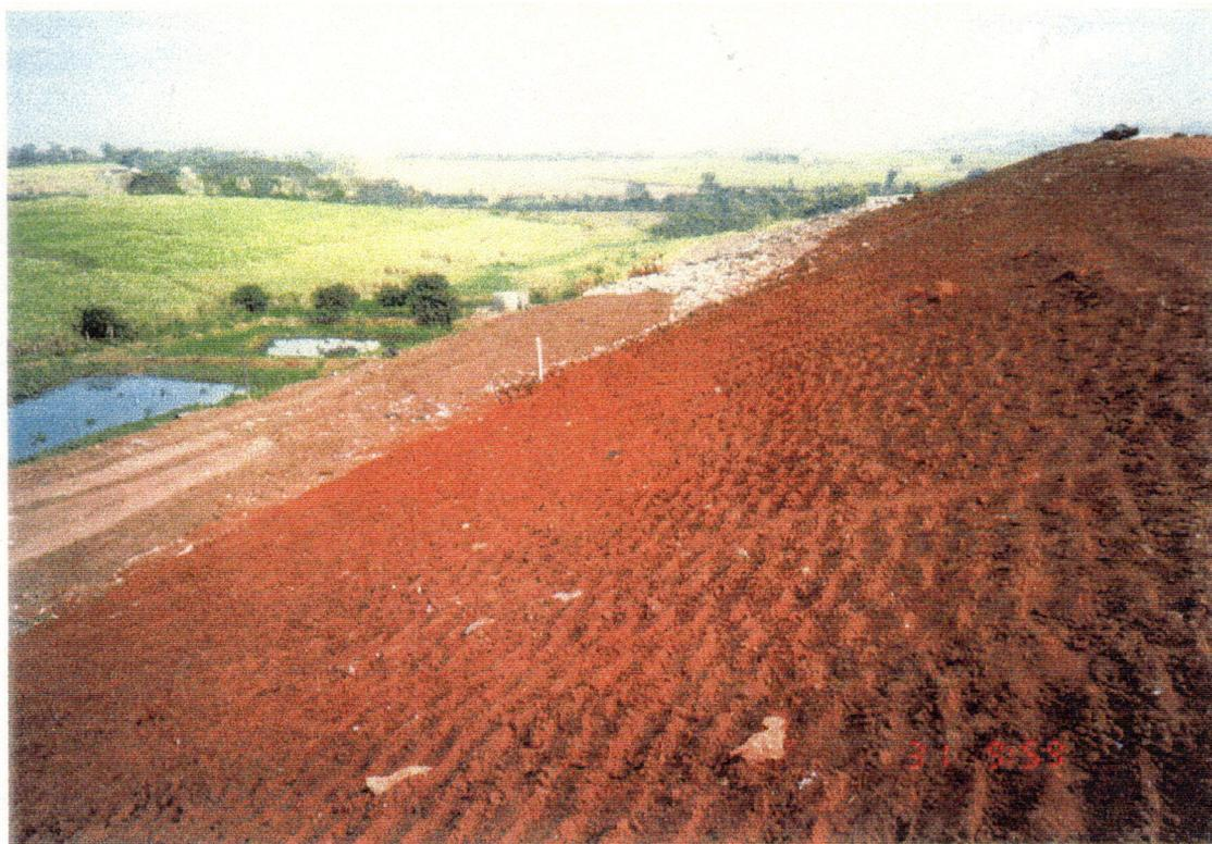
FIGURA 4.5 – Vista de célula acabada, dreno de gás e célula em operação
