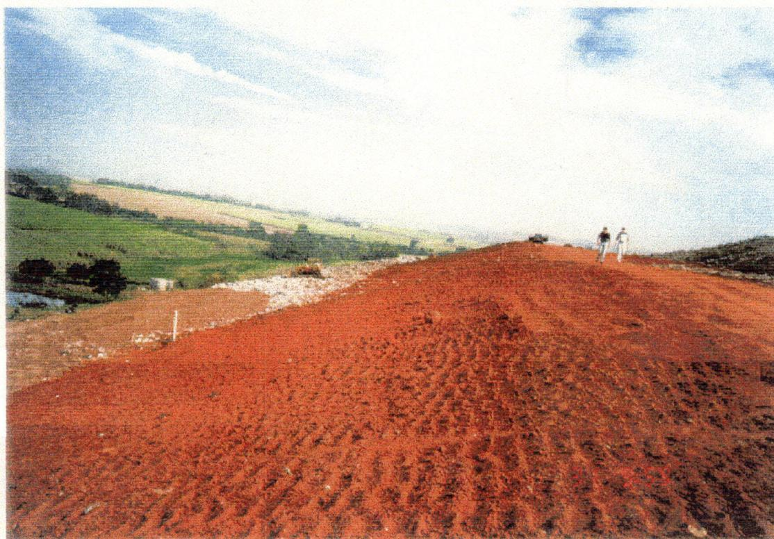
FIGURA 4.6 – Sequência de células em operação, acabada e dreno de gás
