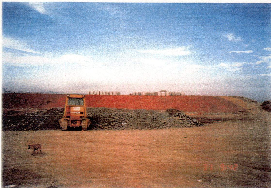
FIGURA 4.3 – Vista do topo do aterro em fase de acabamento
