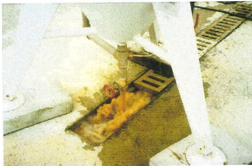
FIGURA 4.13 – Detalhe do tubo de coleta nos pré-filtros de escoamento ascendente
