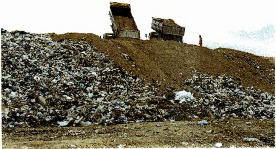
FIGURA 4.3 - Após a compactação do resíduo, este é recoberto por fina camada de terra. (fotografia de operação no Aterro Delta IA).
