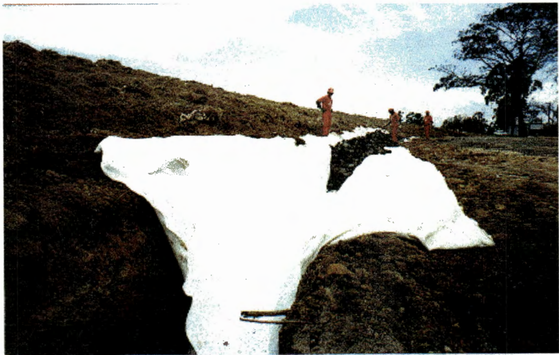
FIGURA 4.4 - Construção de drenos horizontais de líquidos percolados: colocação da manta impermeabilizante antes da disposição do resíduo.
