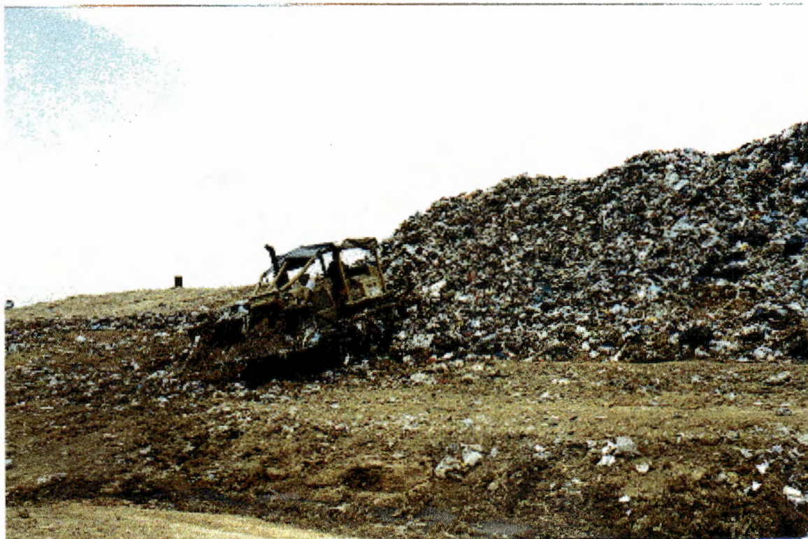
FIGURA 4.2 - Foto mostrando etapa de formação de uma célula no Aterro Sanitário Delta IA: Compactação do resíduo com trator de esteira
