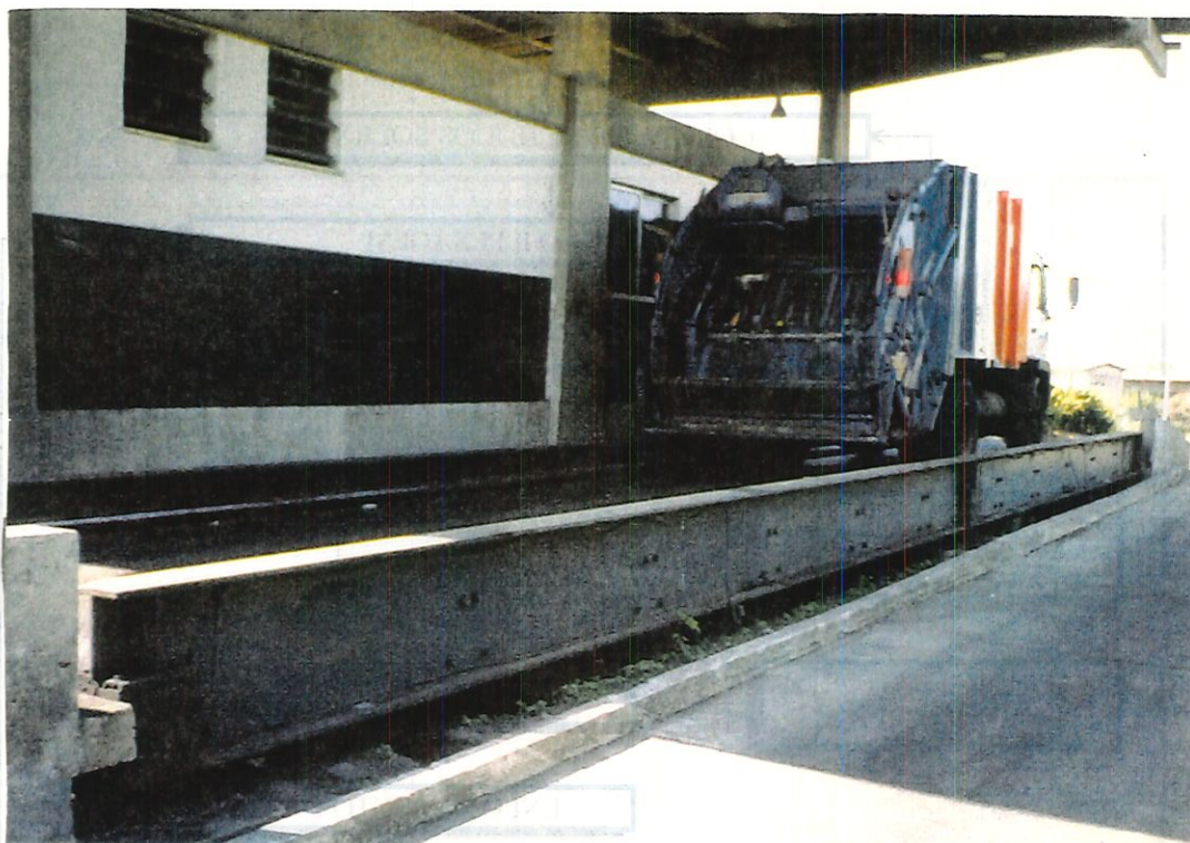
FIGURA 17 - Estação de transferência Caju: coletor na plataforma da balança.
