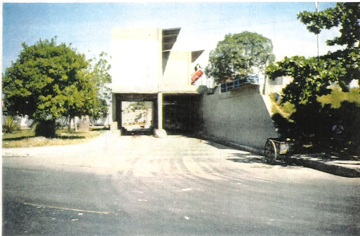
FIGURA 28 - Estação de transferência Caju (rampa): vista frontal da frente de carregamento dos veículos de transporte.
