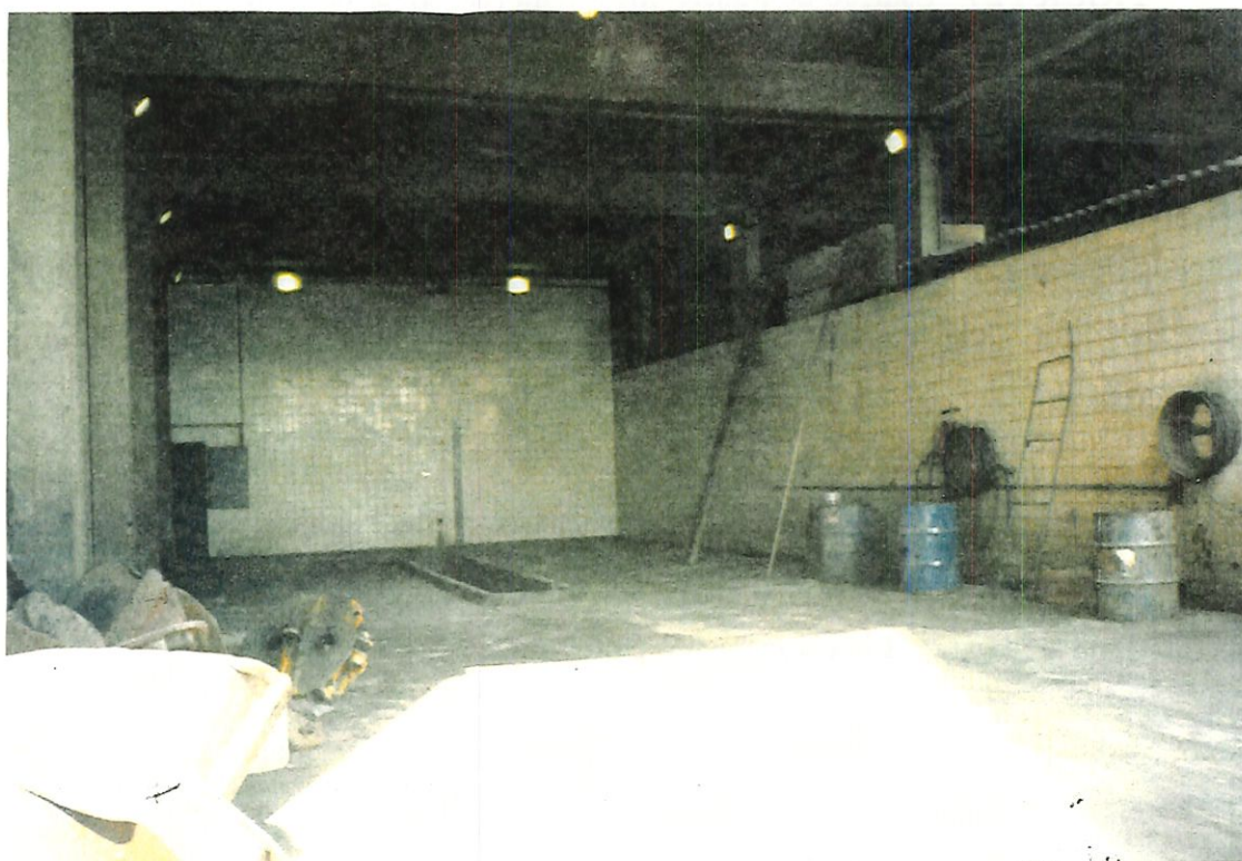
FIGURA 26 - Estação de transferência Vergueiro: unidade de limpeza.
