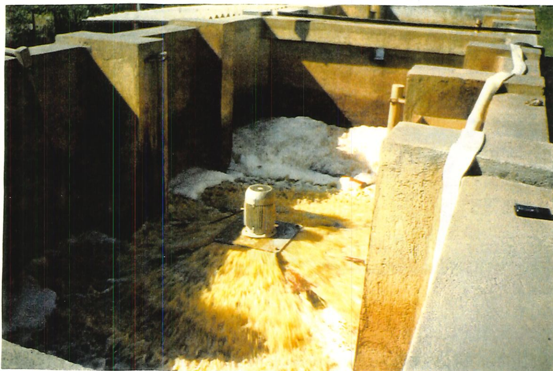
FIGURA 24 - Estação de transferência Caju (usina): sistema de lodo ativado empregado no tratamento do chorume.
