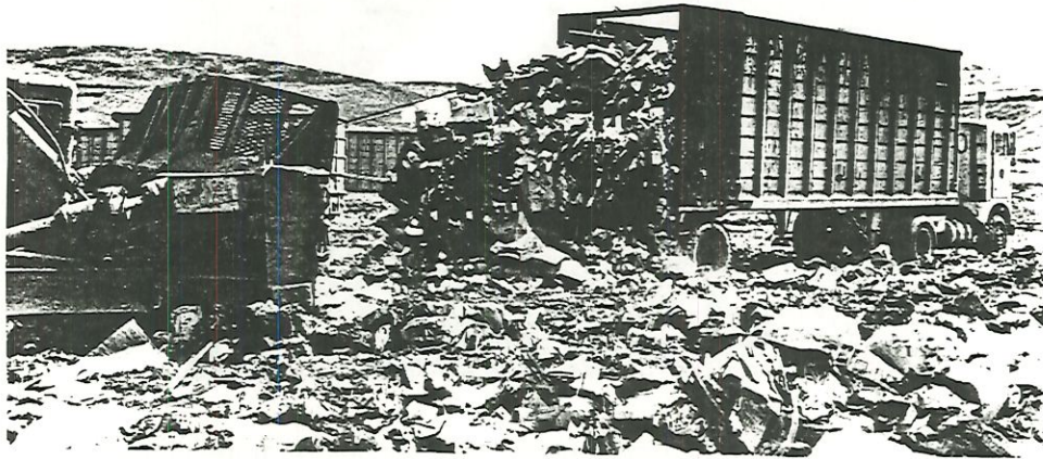
FIGURA 4 - Descarregamento de resíduos por meio de cabos de aço. FONTE: TCHOBANOGLIOUS et al., 1977 , p. 520.
