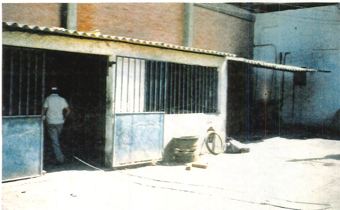
FIGURA 25 - Estação de transferência Bangu: unidade de manutenção.
