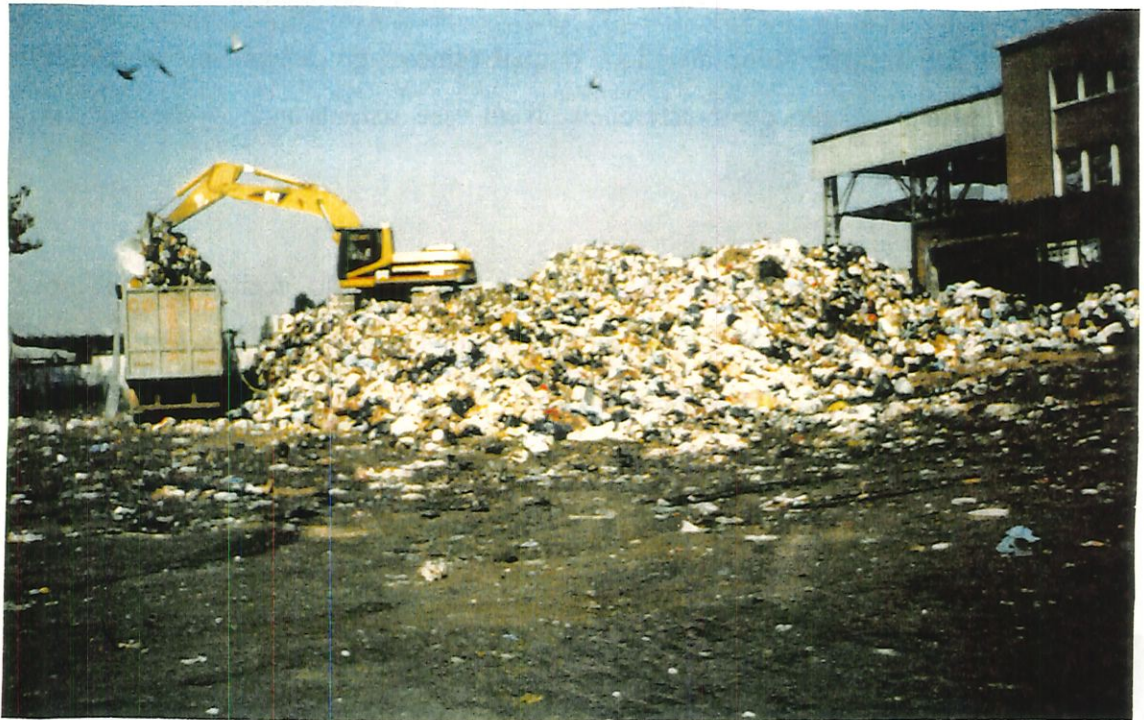
FIGURA 21 - Estação de transferência Ponte Pequena: pátio de acumulação de resíduos, pá mecânica carregando uma carreta de transporte.
