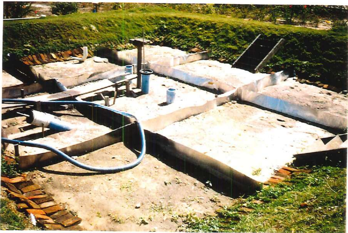
FIGURA A38 - Foto: Colmatação após 2 meses de aplicação de esgoto.
