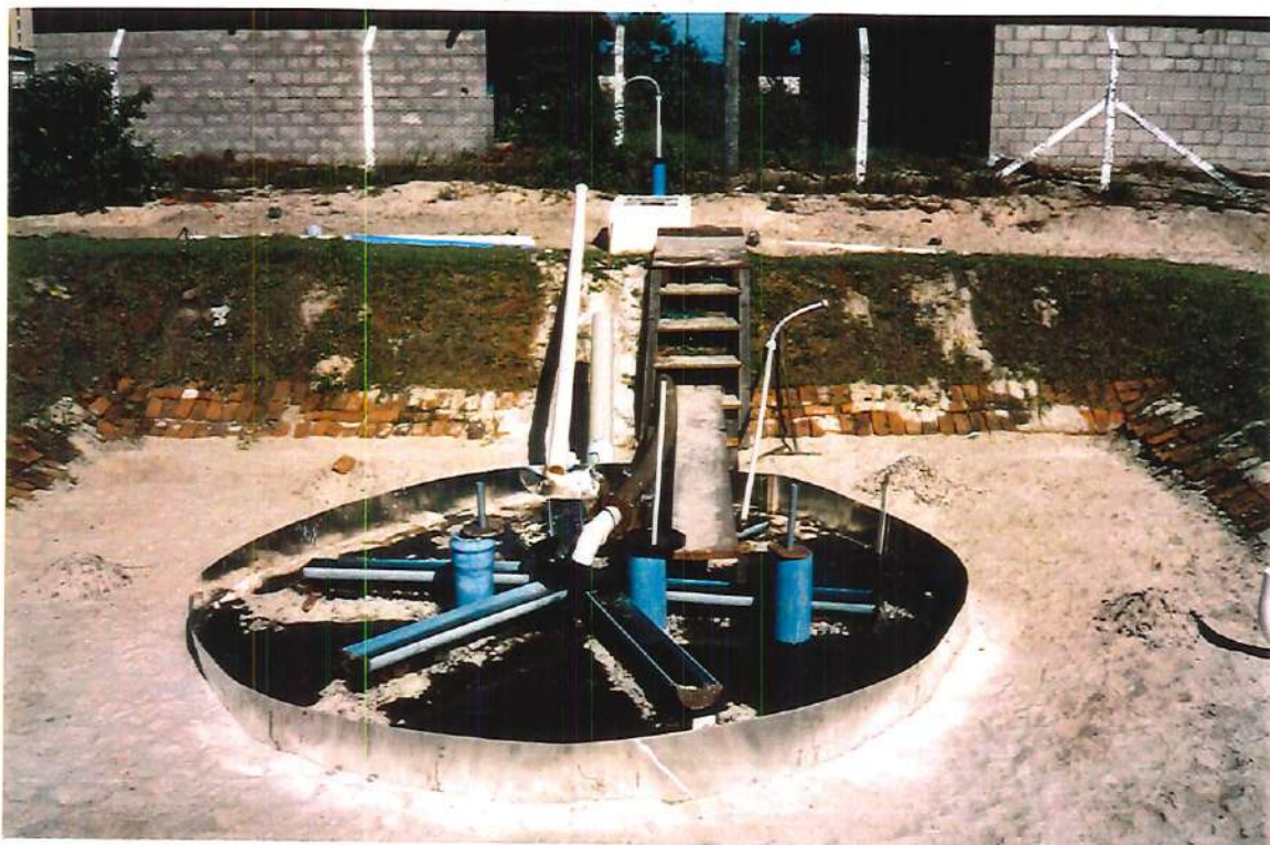
FIGURA A25 - Foto: Sistema de distribuição utilizado na Fase 1.
