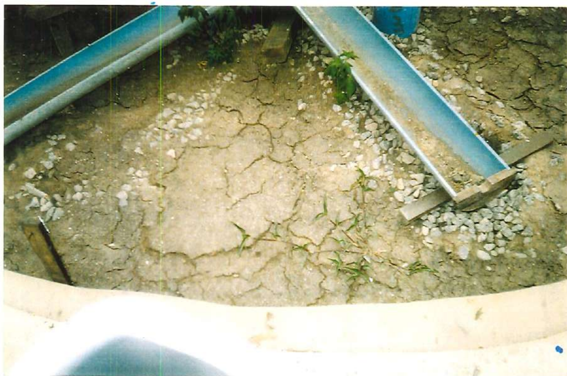
FIGURA A30 - Foto: Colmatção na BIE. Quarto dia após aplicação de esgoto.
