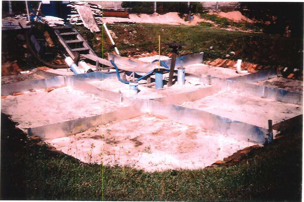
FIGURA A37 - Foto: Colmatação após primeiras aplicações de esgoto.
