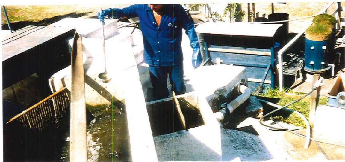
FIGURA A15 - Foto: Limpeza da caixa de gordura (tomada de esgoto).
