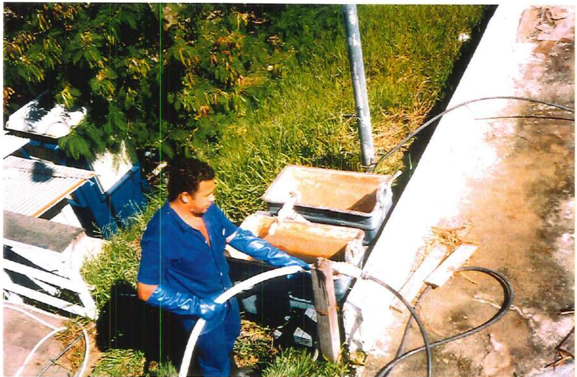
FIGURA A20 - Foto: Preenchimento dos decantadores que abastecem o TDV.
