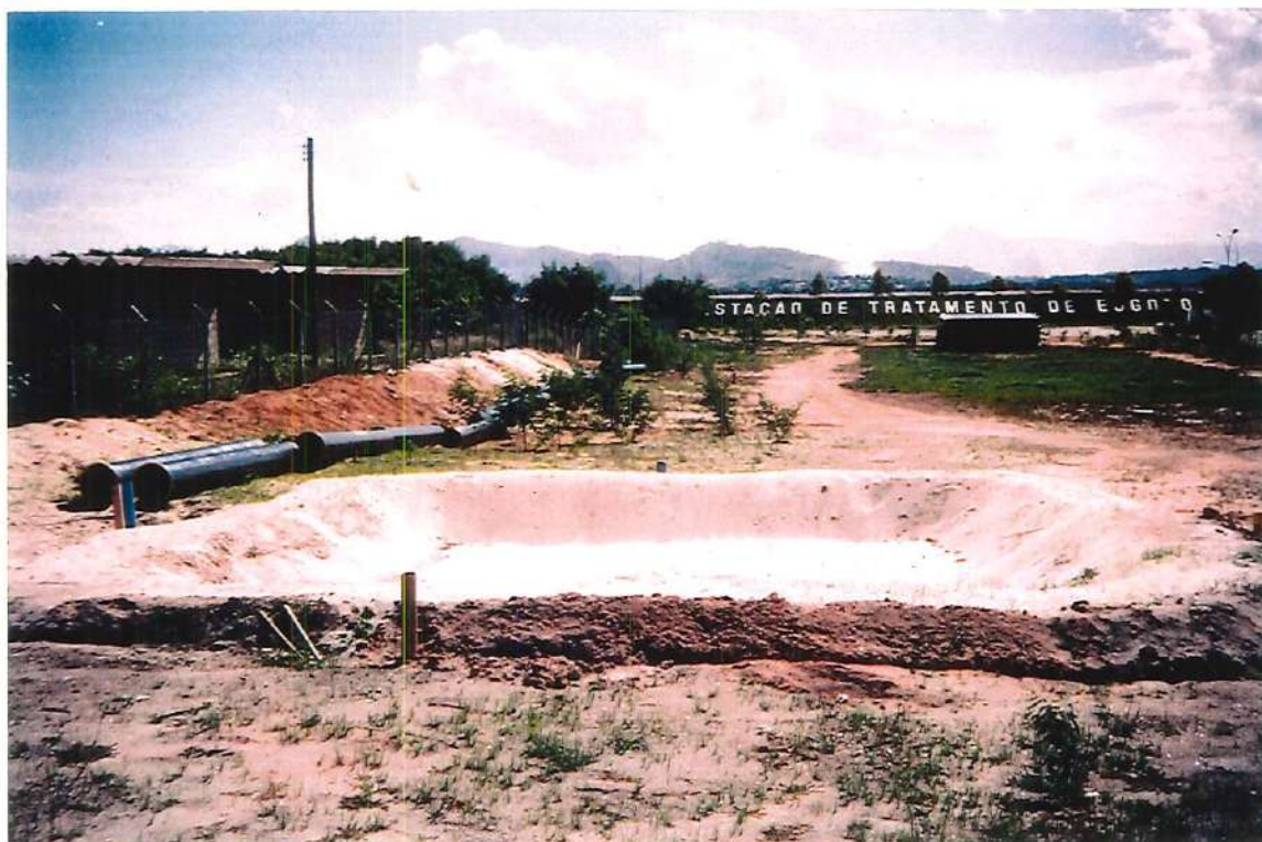
FIGURA A46 - Foto: BIE - ao seu redor 4 piezômetros instalados para coleta de dados nos Estudos Preliminares. Ao fundo, nota-se o relevo degradado e as áreas cobertas com e sem barro.
