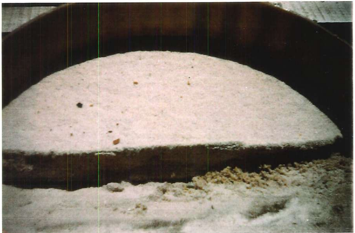
FIGURA A9 - Foto: Colmatação no TQC2 após período de chuvas.
