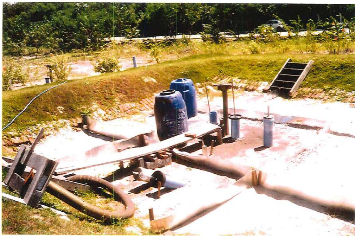
FIGURA A50 - Foto: Aplicação de cloretos no centro da BIE - Poço J.
