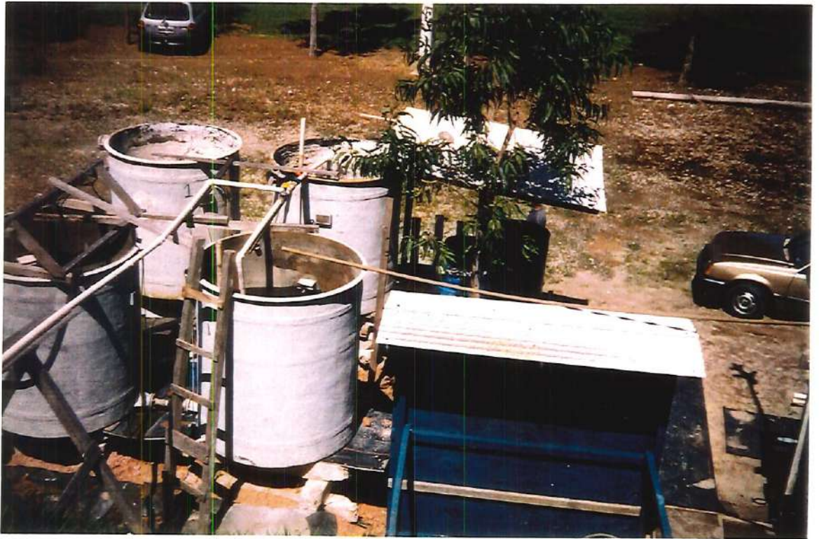
FIGURA A17 - Foto: Vista de cima do preenchimento dos tanques de alimentação.
