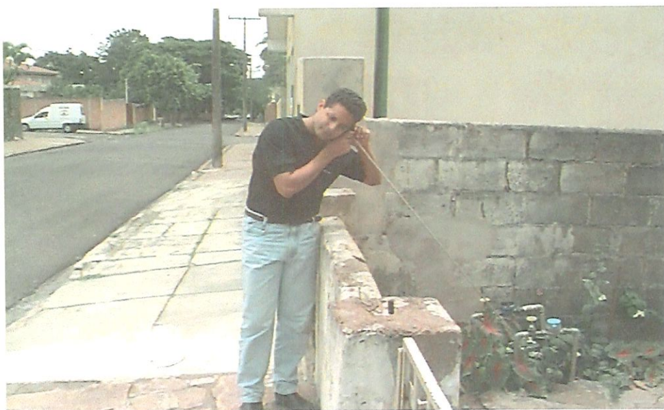
FIGURA 4.4 – Haste de escuta utilizada para identificar vazamentos no pé do cavalete de suporte do hidrômetro residencial.
