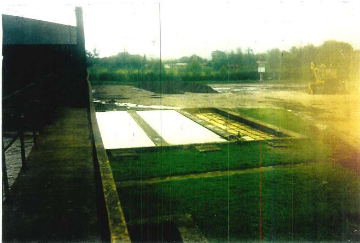
FIGURA B29 - E.T.E. - Leitos de secagem (Jacarepaguá - RJ).
