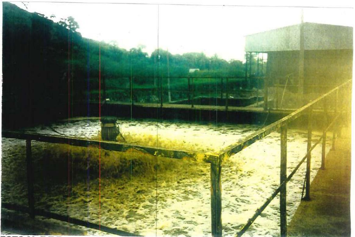
FIGURA B28 - E.T.E. - tanque de aeração (Jacarepaguá - RJ).
