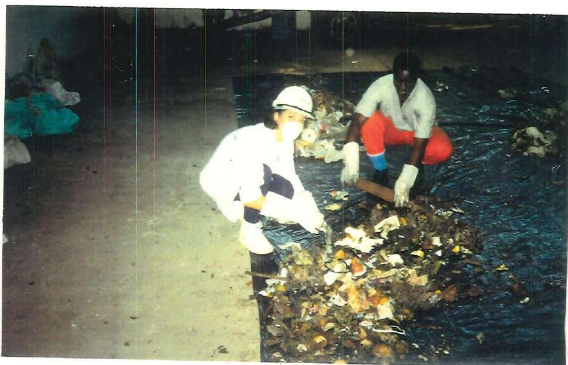
FIGURA B68 - Separação física dos resíduos sólidos da linha de alimentação dos bioestabilizadores (Jacarepaguá - RJ).
