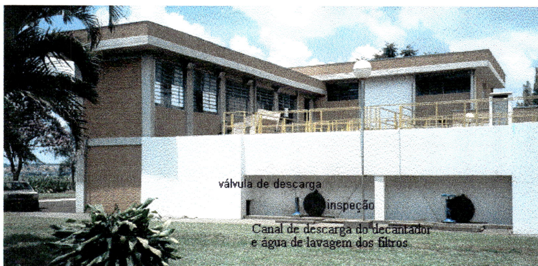
FIGURA 4.6 - Fotografia mostrando uma vista geral da ETA e do canal de descarga do decantador e água de lavagem dos filtros.
