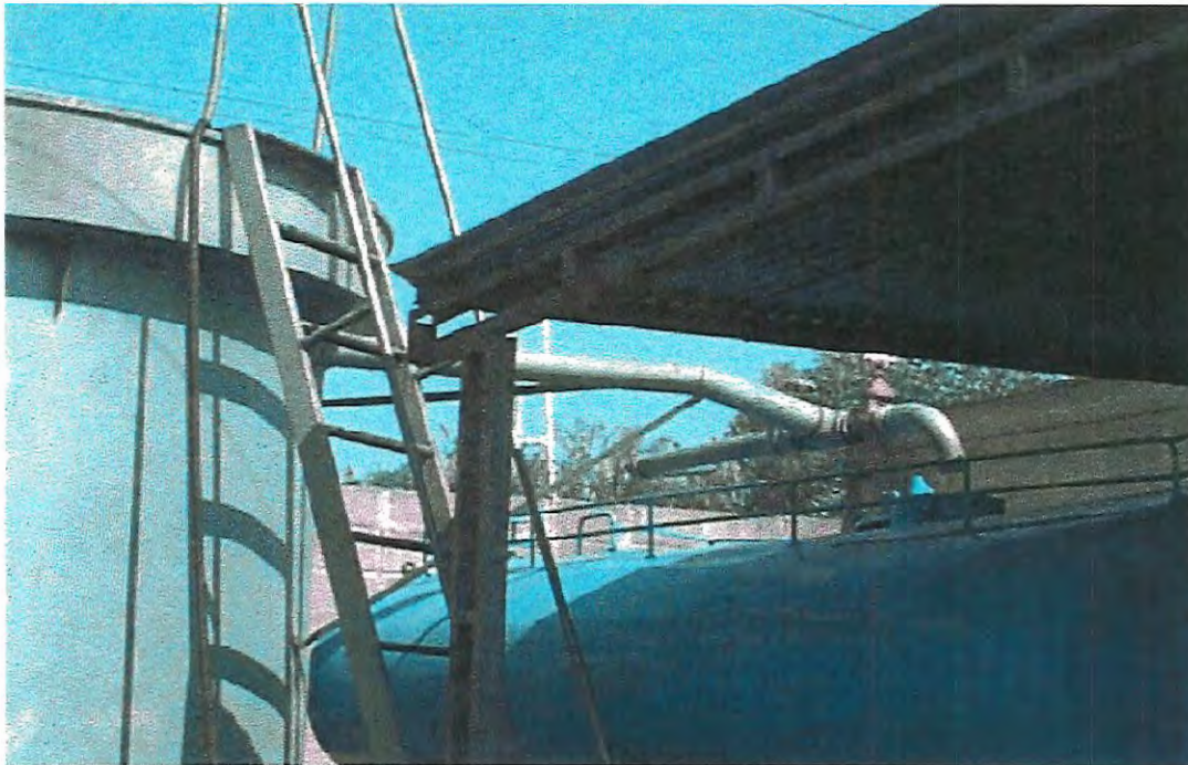
A – Vista lateral do flotador onde aparece a canalização de descarga do lodo superficial
