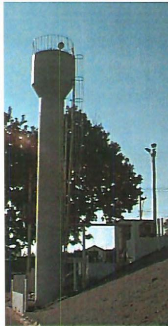
**FIGURA 11** – Reator Anaeróbio de Leito Expandido, Escola de Engenharia de São Carlos – USP.
