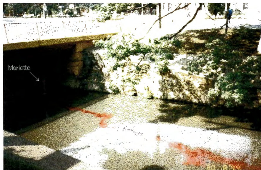
Figura 5.16 - Injeção contínua da rodamina no escoamento sob a Ponte da Rua Amazonas. Teste de reaeração no Ribeirão de Caldas, em 30/08/94.
