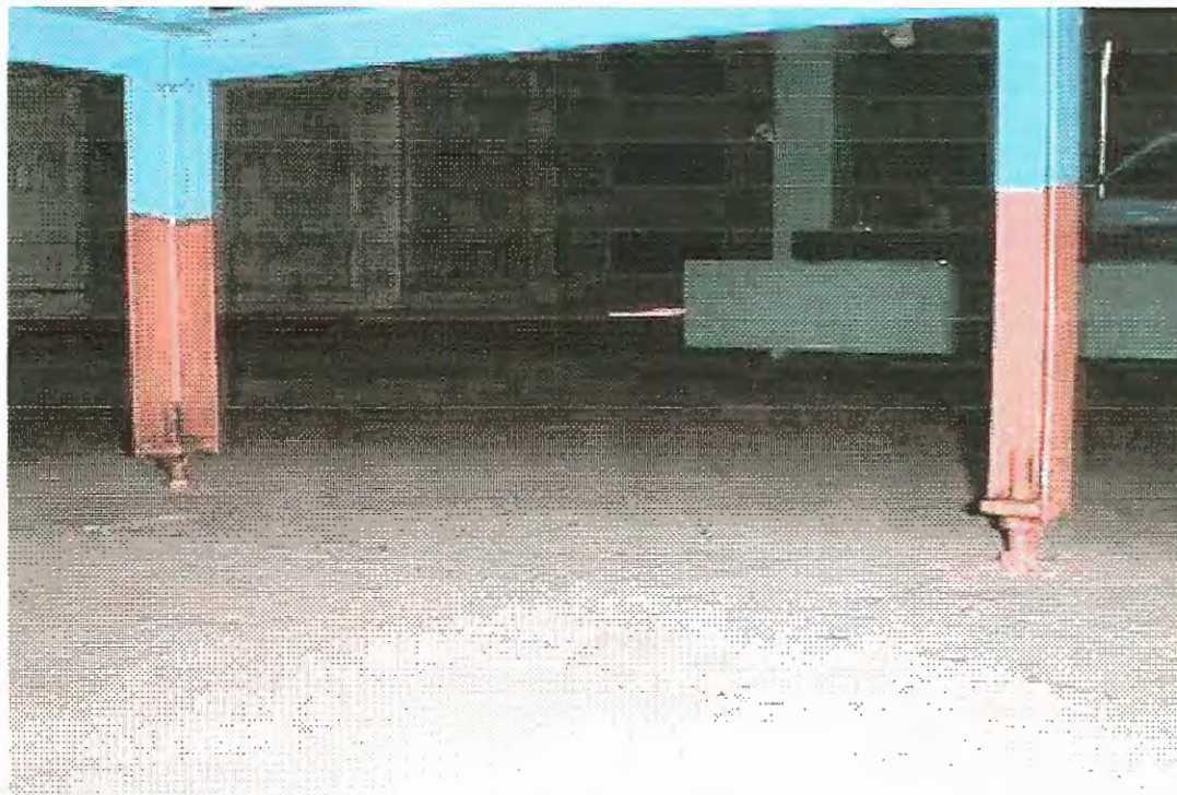
FIGURA 21 – Sistema de controle de nível nos apoios da mesa de suporte
