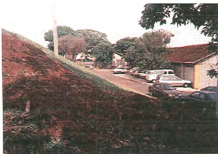
Figura 4.8: Fotografia 2 da Área Cedida para Instalação da ETE em Escala Real.
