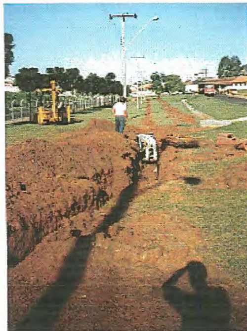
Figura 4.9: Remanejamento da Tubulação de Saída da ETE.
