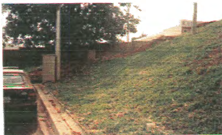
Figura 4.7: Fotografia 1 da Área Cedida para Instalação da ETE em Escala Real.
