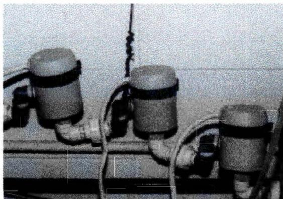
FIGURA 12 - Fotografia dos aquecedores elétricos instalados na tubulação à montante da unidade de mistura rápida.
