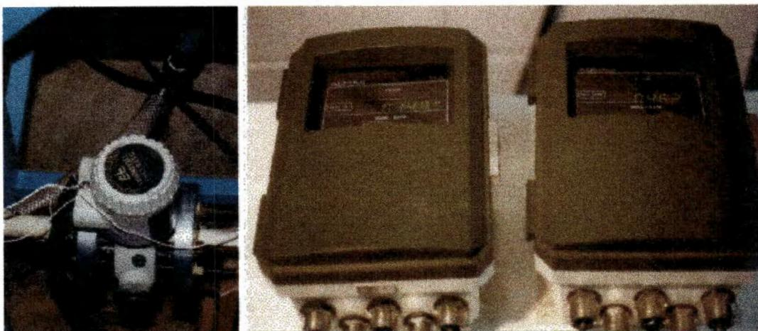
FIGURA 14 - Fotografia do medidor da vazão afluente à instalação com escoamento contínuo, instalado à montante da unidade de floculação e fotografia dos conversores eletromagnéticos de vazão.
