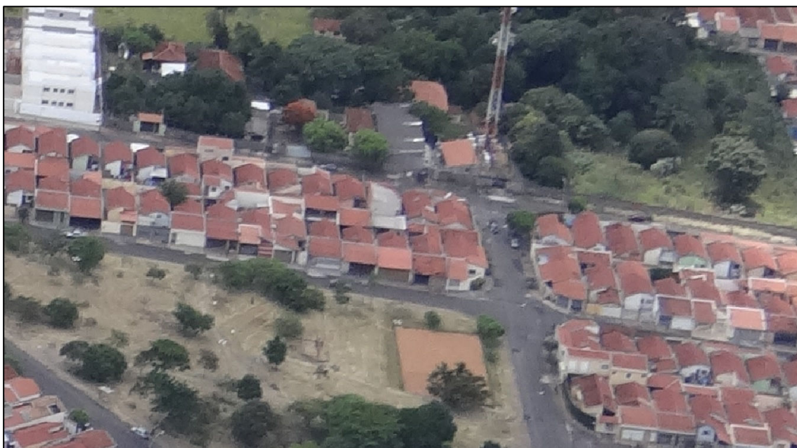
Figura 61: Fotografia aérea das imediações do Ponto 10. Fonte: QUAPÁ-SEL (2014).
