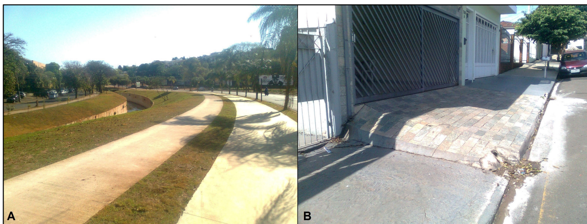
Figura 8: (A): Espaços Livres às margens do Córrego do Gregório, Av. Comendador Alfredo Maffei, na região central de São Carlos-SP; (B): Nivelamento das calçadas inadequado para a circulação de pedestres na Rua Crisântemos, região norte de São Carlos-SP. Fonte: Acervo pessoal (2013).
