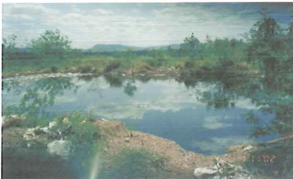
Figura 10 - 1ª Lagoa de líquidos percolados destinados à recirculação.
