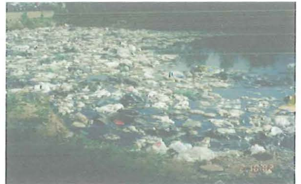
Figura 11 - 2ª Lagoa de líquidos percolados destinados à recirculação.
