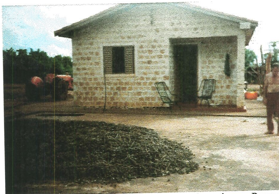
Figura - 1.3: Habitações construídas em alvenaria no Reassentamento Populacional da Fazenda Laranjeiras/Narandiba-SP. (Área construída = 50 m 2 distribuídos em 3 quartos, sala, cozinha e banheiro com instalações sanitárias, fossa séptica, energia elétrica e poço.
