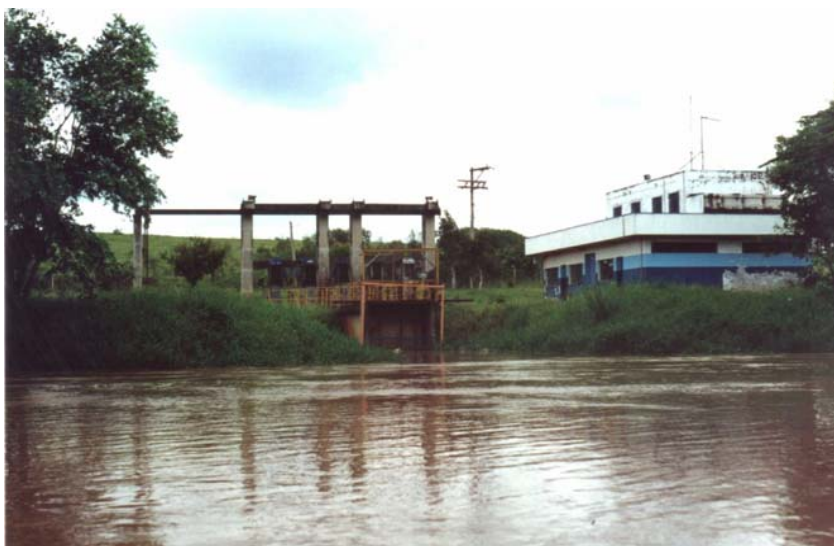
Figura 3. Estação de captação de Sumaré, no rio Atibaia (SP)
